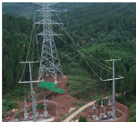
NC7 塔基及车行便道
