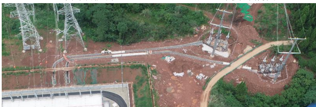
电缆工程施工作业带
