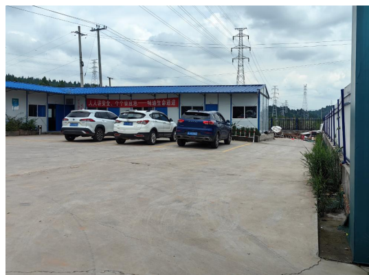
施工营地内场地硬化
