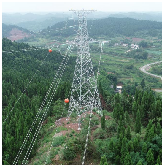
NA19 塔位及人抬道路
