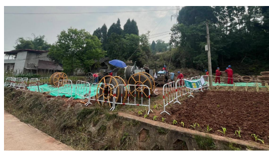
NA17 塔位附近牵张场--临时隔离遮盖
