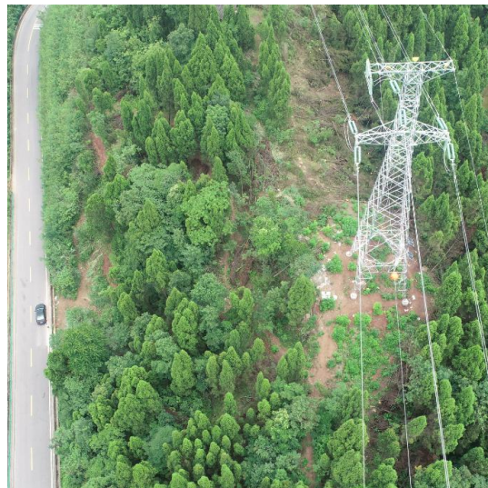
NA18 塔位及人抬道路
