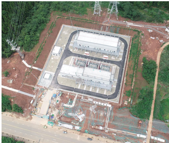
变电站站区建构筑物施工
