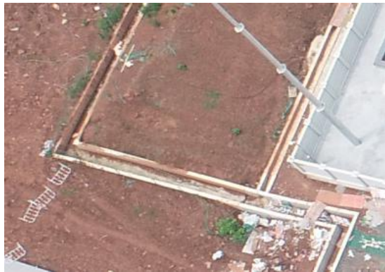
变电站站区截水沟和边坡遮盖
