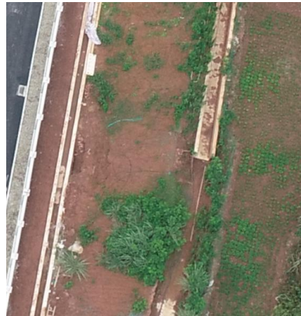
变电站站区截水沟（未施工完）和边坡绿化
