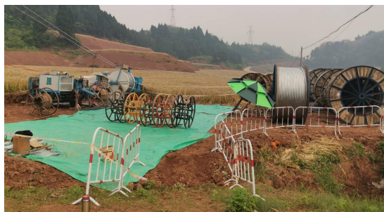
NA10 塔位附近牵张场--临时隔离遮盖
