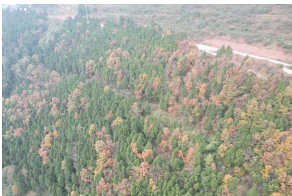
图片 4-2 线路I沿线地形地貌
