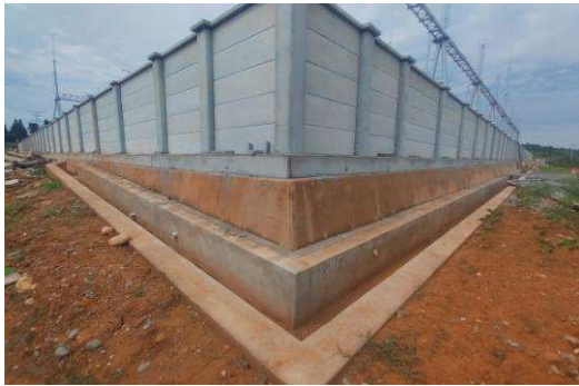
站外截排水沟现状
