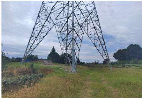
NA85 号塔基施工场地现状
