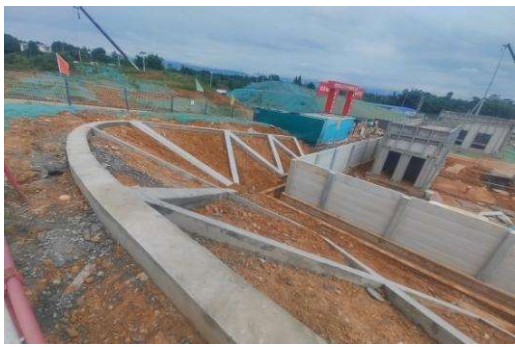
站区框格植草护坡施工现状
