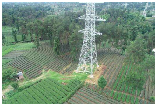
NA81 塔基施工场地现状
