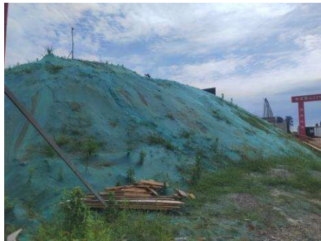
边坡临时遮盖
