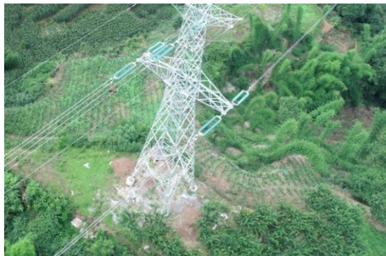
图 4.3-2 NB46 基面有建渣、未进行植被恢复
