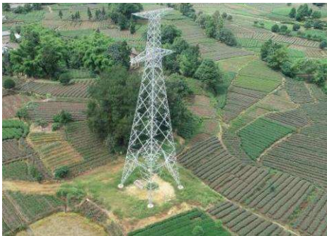
NB78 号塔基施工场地现状
