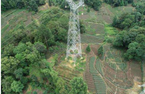
NB55 塔位施工场地现状
