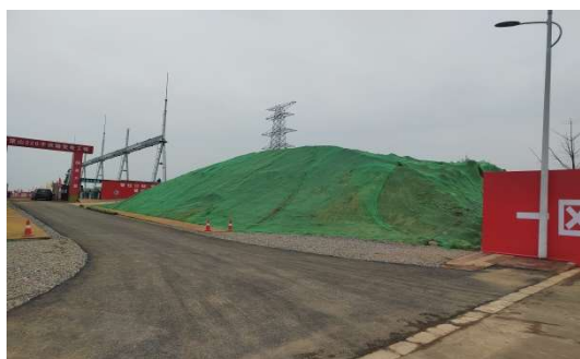
进站道路植物护坡尚未实施
