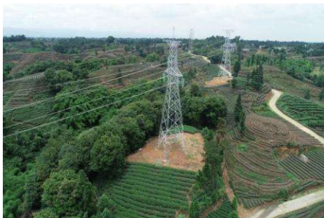
NA58 塔位施工场地现状
