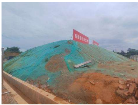
边坡临时遮盖
