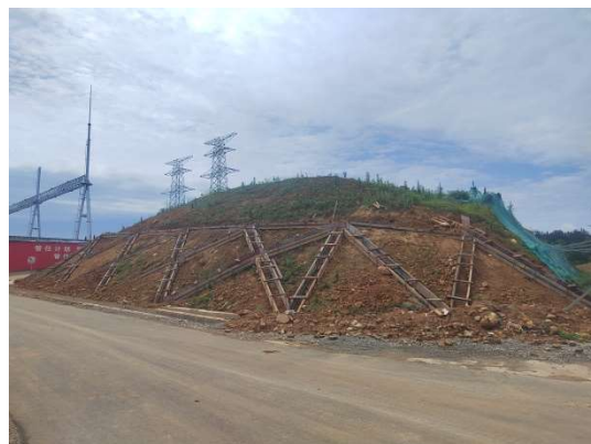
进站道路植物护坡施工中
