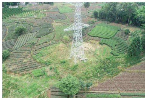
NA75 号塔基施工道路现状
