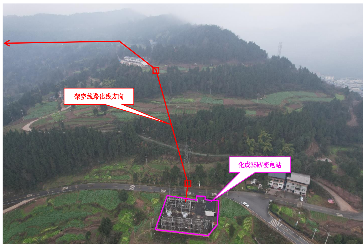
化成 35kV 变电站出线情况
