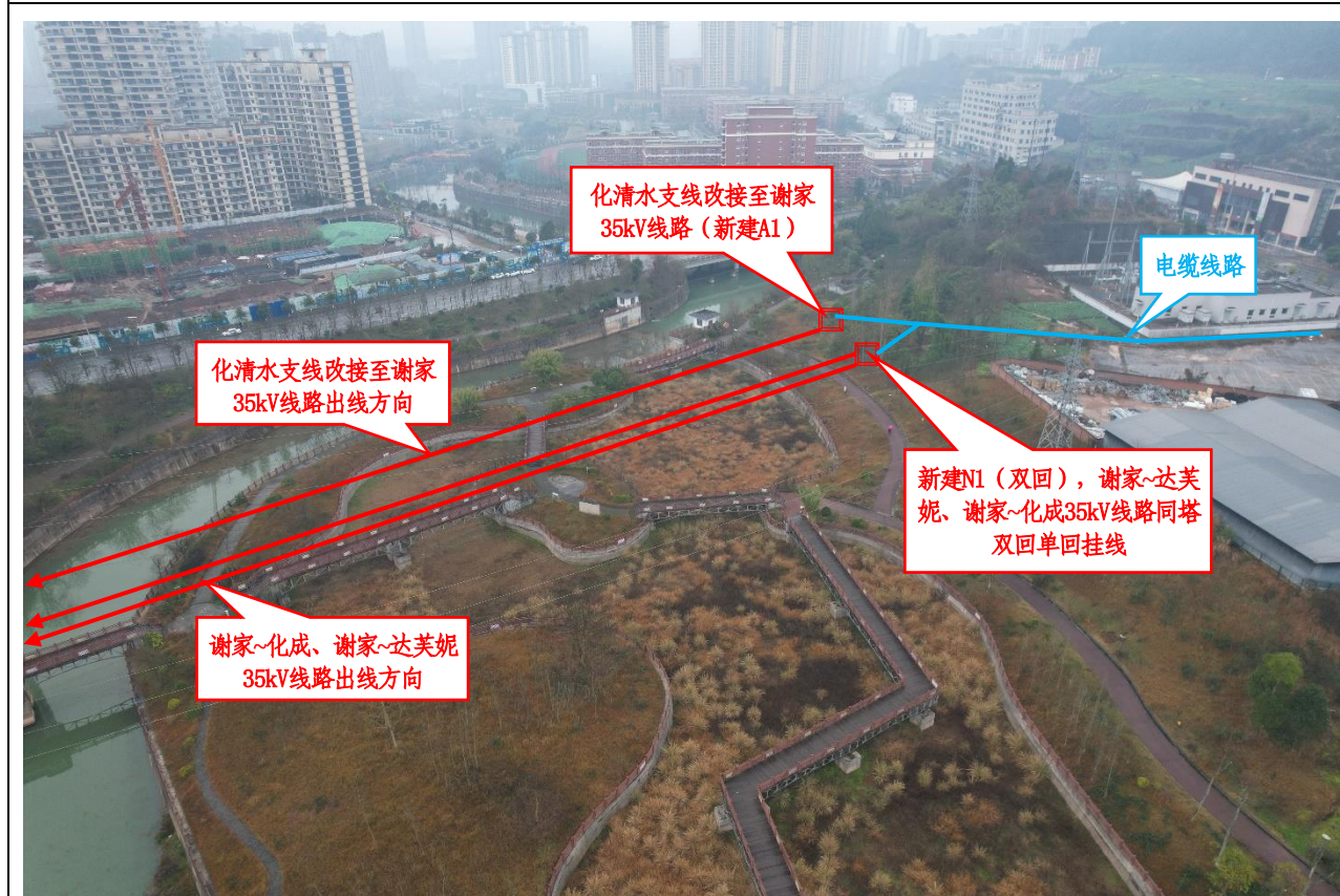
谢家 110kV 变电站出线情况
