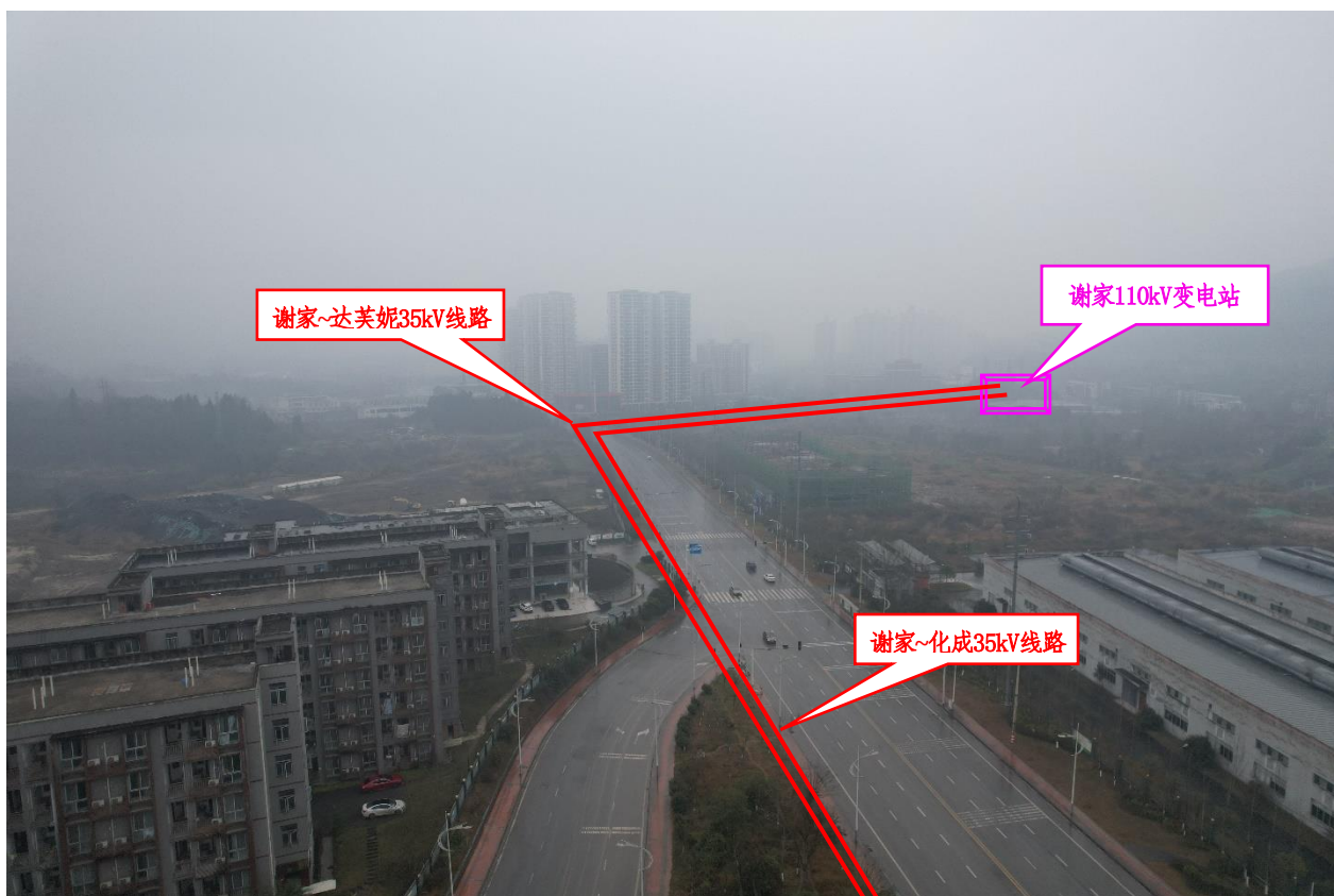
谢家~达芙妮 35kV 线路工程项目区照片
