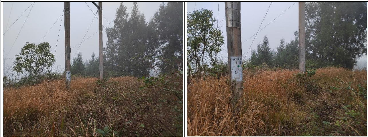
35kV 化清水支线 1#杆（拆除）
