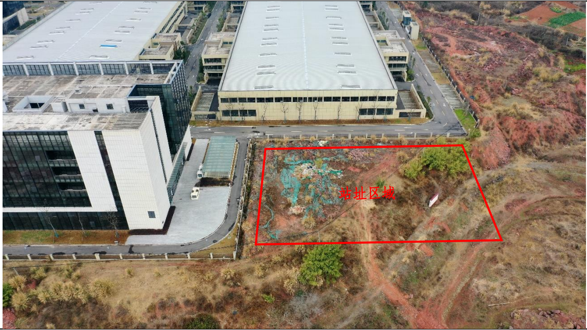
城金变电站站址现状
