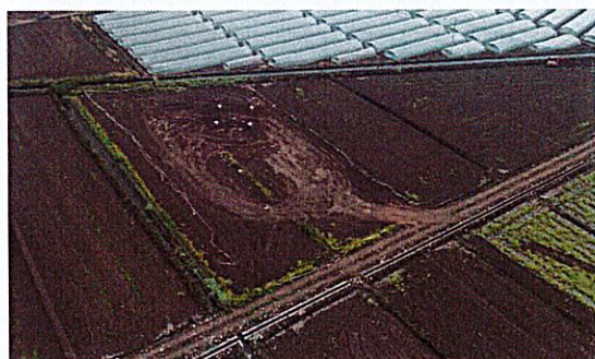
N60 塔位及施工道路
