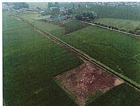
N78 塔位及施工道路
