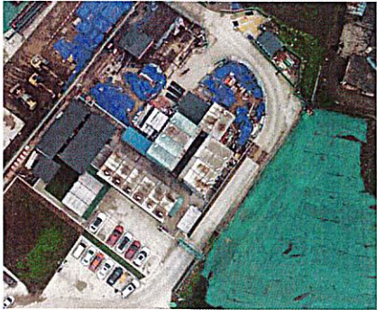
储能项目预留区临时遮盖
