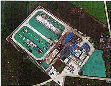
变电站主体工程区全景
