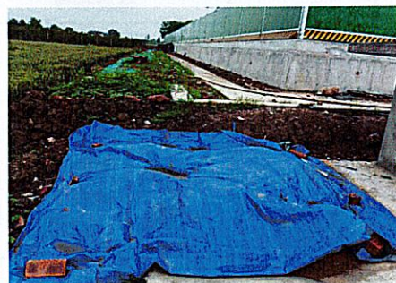
储能项目预留区临时遮盖
