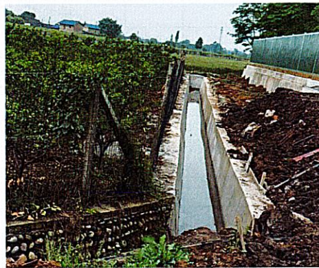
变电站主体工程区排洪沟
