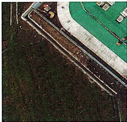
变电站主体工程区排洪沟
