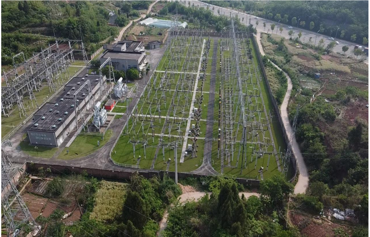
图 2-2 南充大方 220kV 变电站现状照片
