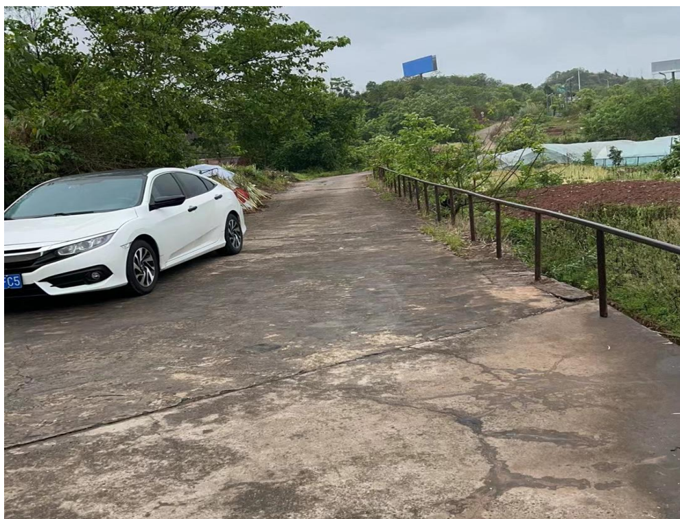
南充大方 220 千伏变电站已建进站道路
