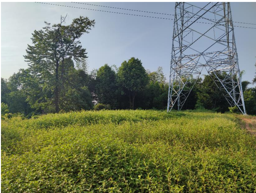
云台～百花村牵 220kV 线路工程-塔基及周边占地区域恢复现状
