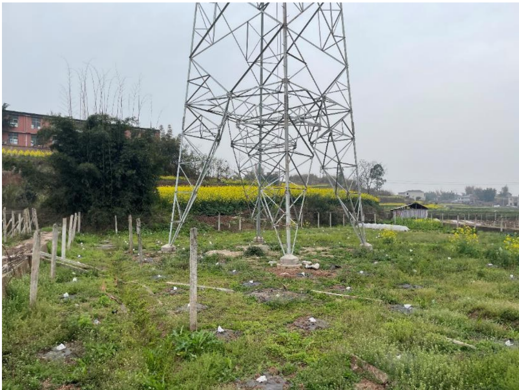
高石～百花村牵 220kV 线路工程-塔基及周边占地区域恢复现状
