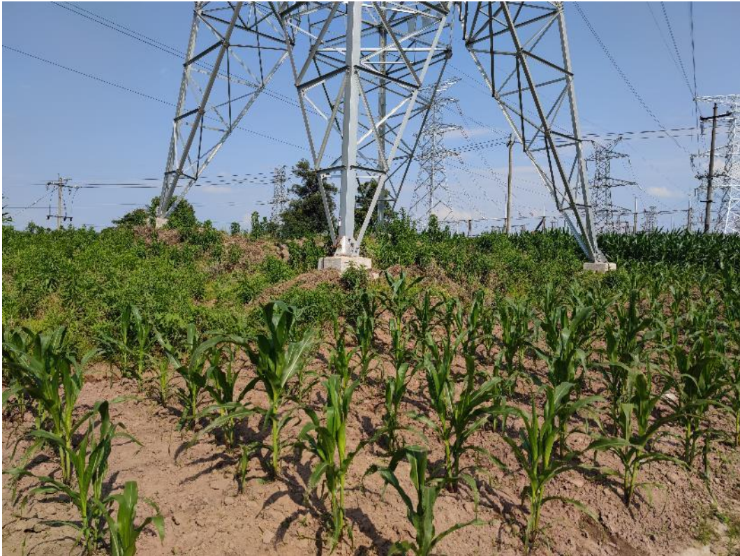
高石～百花村牵 220kV 线路工程-塔基及周边占地区域复耕现状
