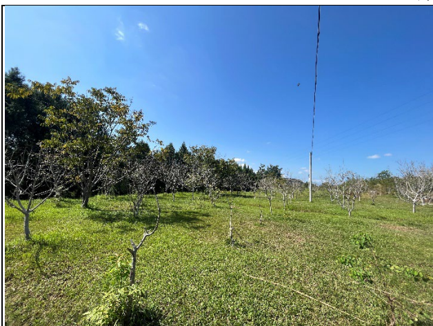
双板 35kv 变电站
