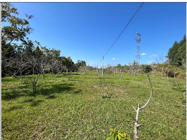
双板 35kv 变电站
