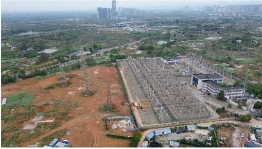
大面220kv变电站未设置碎石压盖
