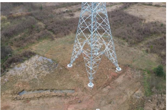
NB2塔位现状（已开展土地整治）
