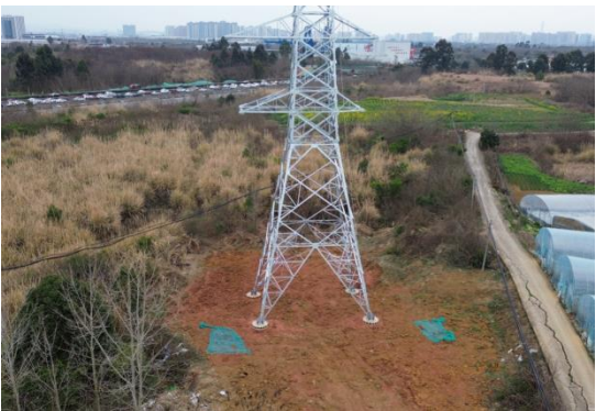
NA5塔位现状（已开展土地整治）
