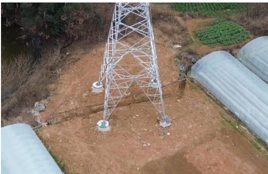
NA20塔位现状（设置排水沟、开展土地整治）
