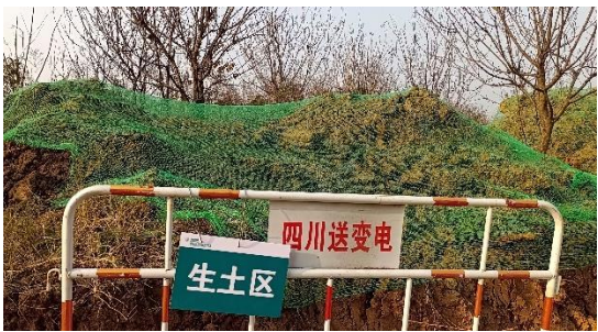
生土堆放区（设置临时苫盖）
