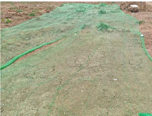
塔基现状（设置土地整治、临时苫盖）
