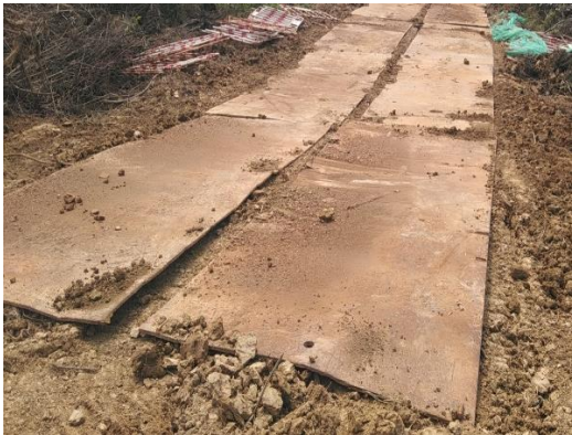
道路按水保方案设置钢板铺垫
