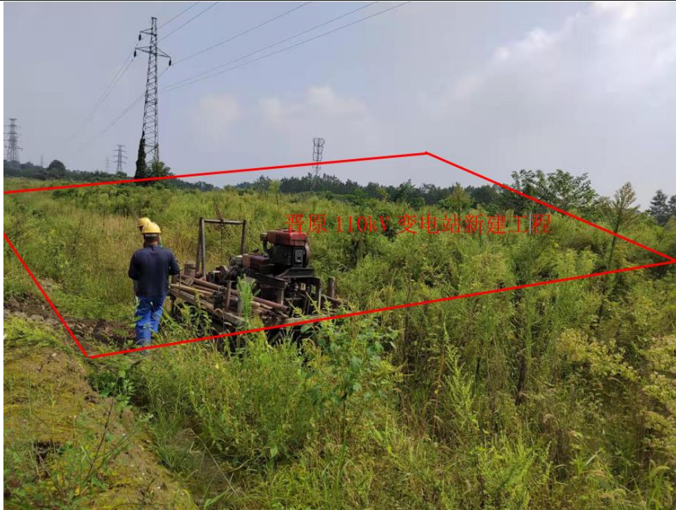
晋原变电站站址现状
