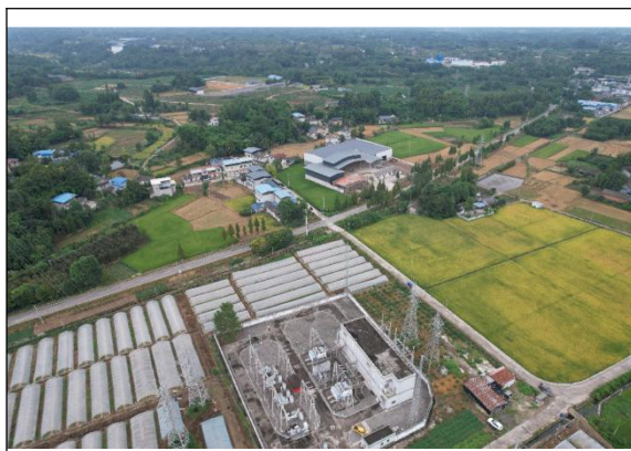
秀水 110KV 变电站
