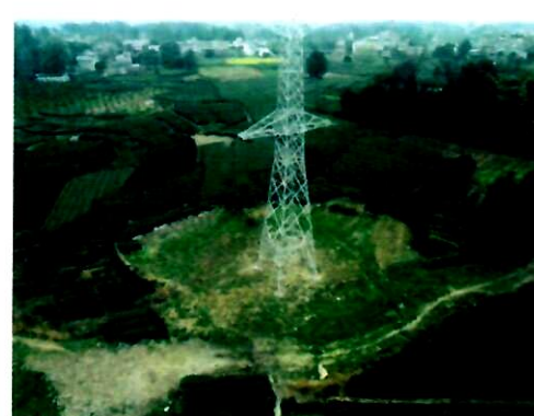
NA75 号塔基施工道路现状
