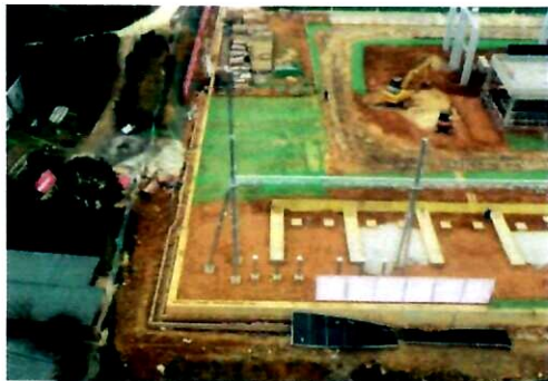
站外截排水沟施工现状
