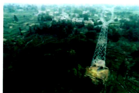
NB55 塔位施工场地现状
