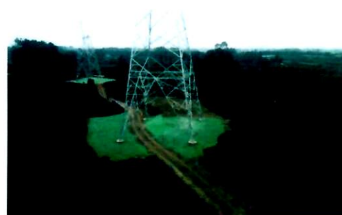
NA85 号塔基施工场地现状
