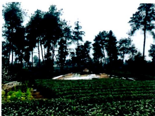
NA81 塔基施工场地现状
