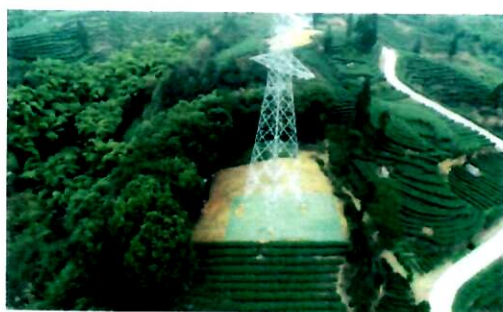
NA58 塔位施工场地现状
