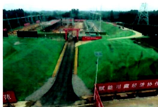
站区、进站道路边坡密目网遮盖
