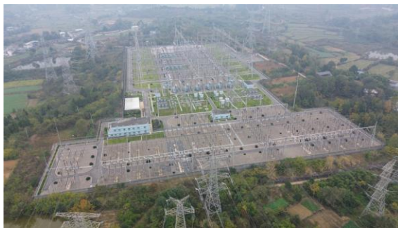
图片 4-1 变电站区域现状
