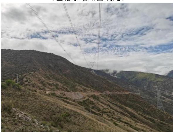
图片 4-3 线路沿线地形地貌 (既有 500kV 苏塘线开断点)
