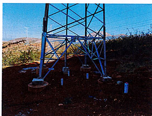
新建塔基区域现状
