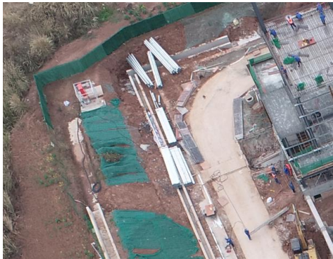
变电站站区截水沟（未施工完）和边坡遮盖
