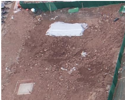
施工临时设施区临时遮盖
