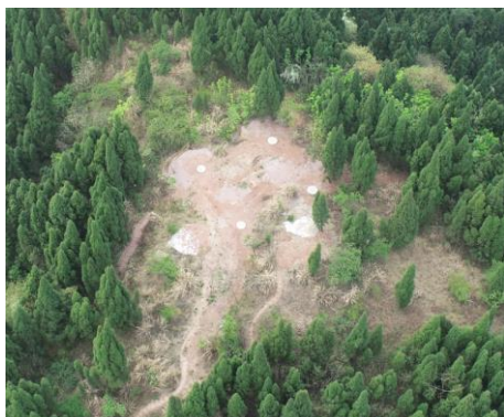
NA19 塔位及人抬道路
