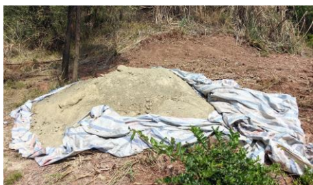
塔位临时铺垫隔离
