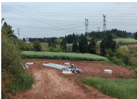
NA1 塔位及车行便道
