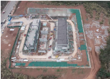
变电站站区建构筑物施工
