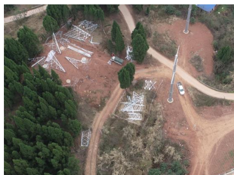
NC7 塔基及车行便道
