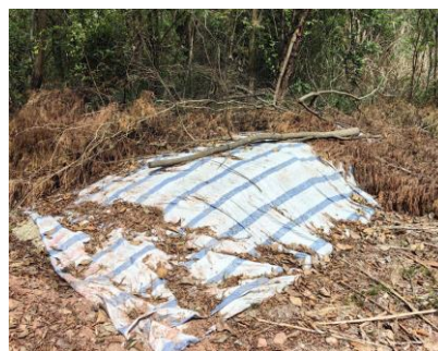
塔位堆土临时遮盖
