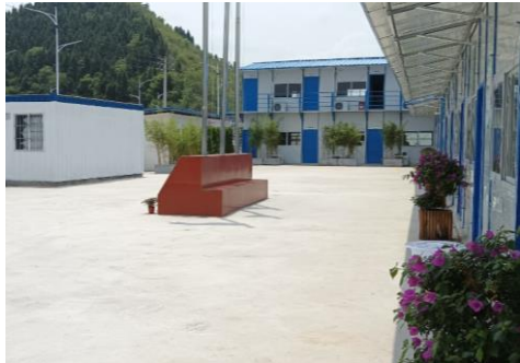
施工营地内场地硬化
