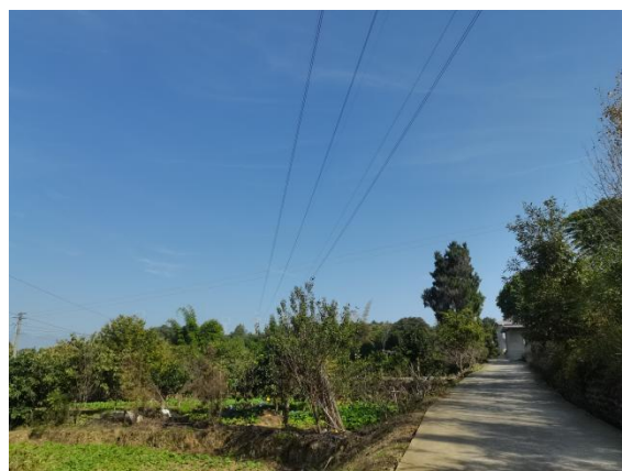
图 3-5 既有 220kV 江河一线现状
