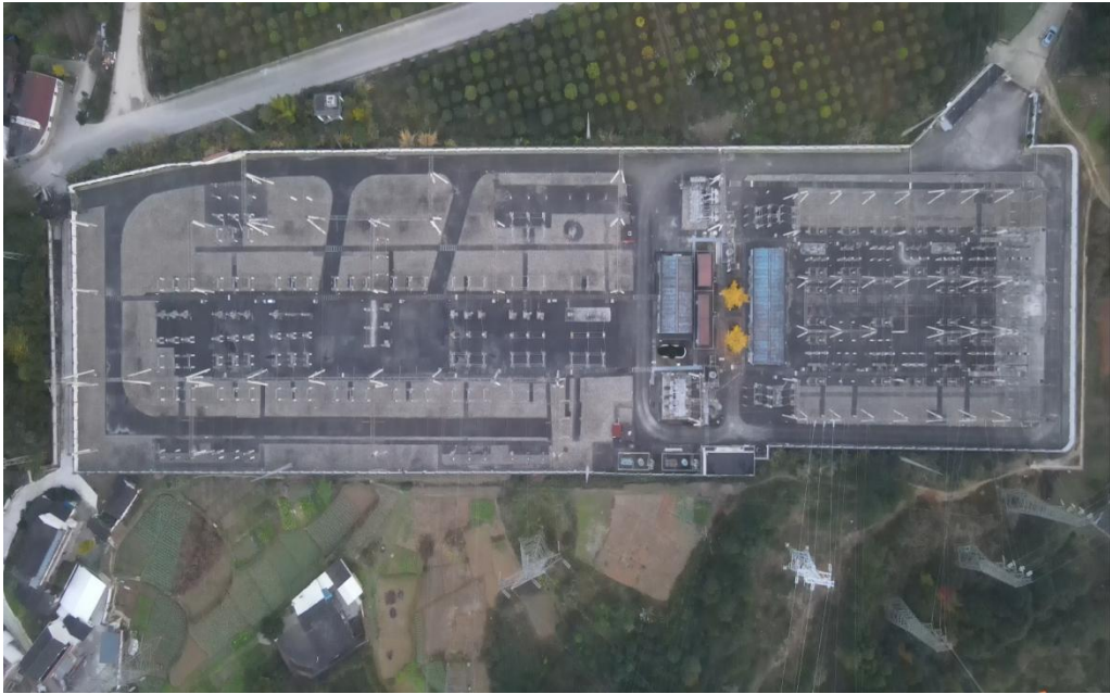
图 3-2 既有大康 220kV 变电站现状
