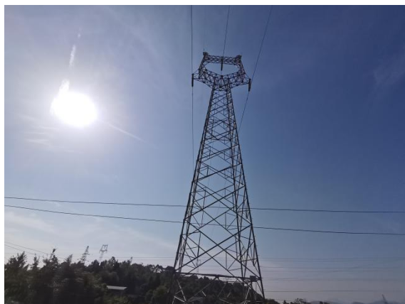
图 3-4 既有 220kV 江河二线现状
