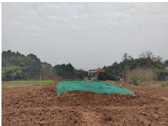
图 4.3-2 N10 号塔基表土、余土未进行摊平处理 图 4.3-3 N14 号塔基表土、余土未进行摊平处理
