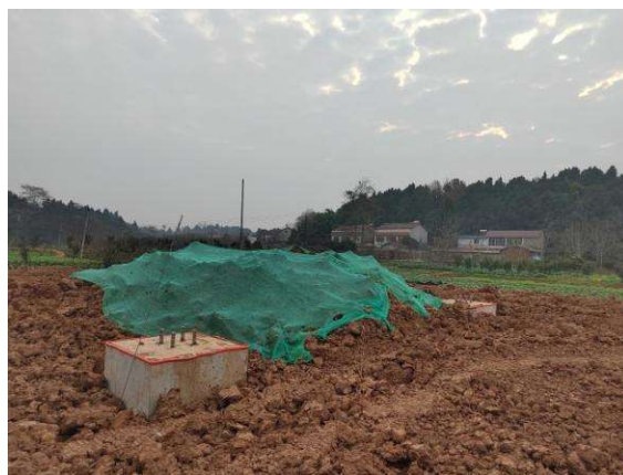
图 4.3-2 N10 号塔基表土、余土未进行摊平处理 图 4.3-3 N14 号塔基表土、余土未进行摊平处理
