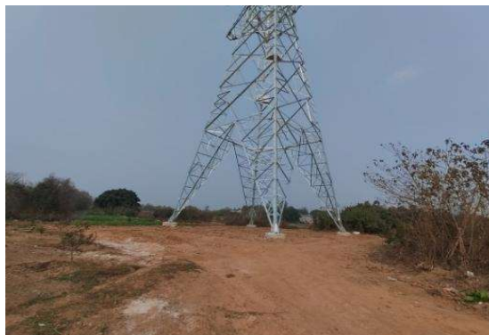
NR7 号塔施工场地土地整治
