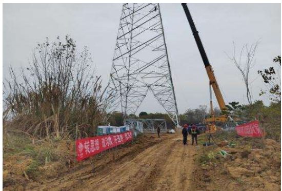
NL11 号塔场地现状
