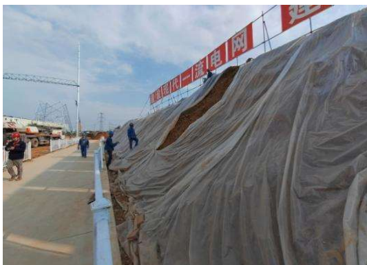
变电站边坡临时遮盖
