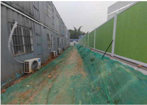
变电站施工生产生活区临时遮盖
