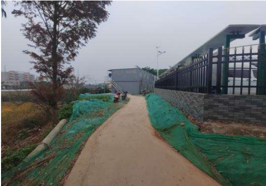
变电站施工生产生活区临时遮盖
