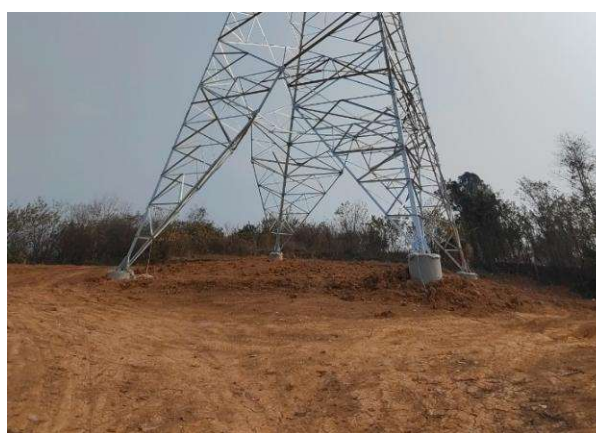
图 4.4 NR6 号塔余土摊平处理后
