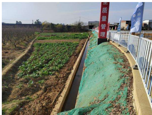
图 4.2 进站道路排水沟清理后
