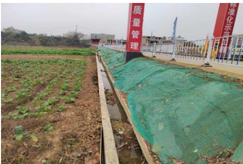
进站道路边坡临时遮盖
