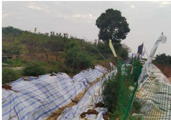
变电站临时排水沟临时隔离
