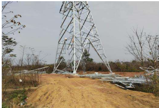
NL12 号塔施工场地土地整治
