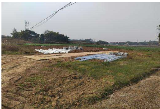
NR5 号塔施工道路钢板铺设
