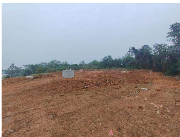
图 4.3 NR6 号塔余土未摊平处理
