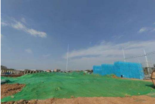
站区表土临时遮盖
