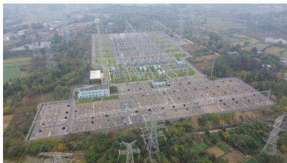
图片 4-1 变电站区域现状
