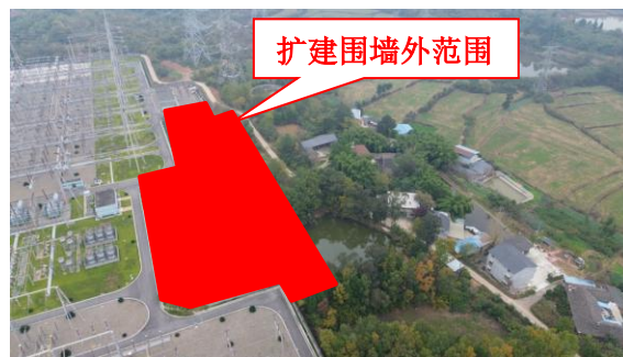
图片 4-2 本次围墙外扩建区域现状
