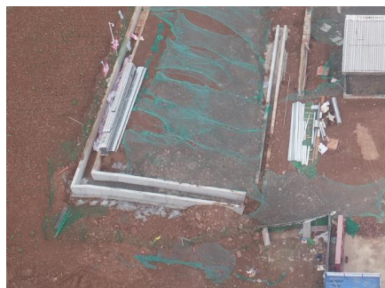
变电站站区截水沟（未施工完）和边坡遮盖
