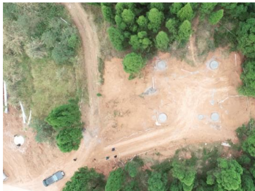
NC7 塔基及车行便道
