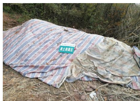
塔基表土剥离防护
