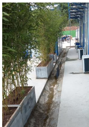
施工营地内排水沟
