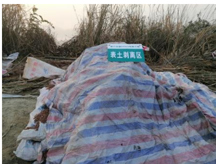
塔基表土剥离防护
