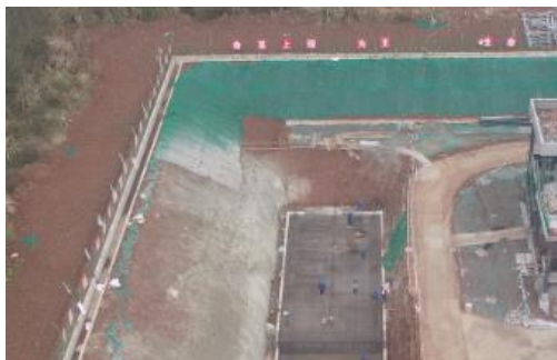
变电站站区截水沟和边坡遮盖
