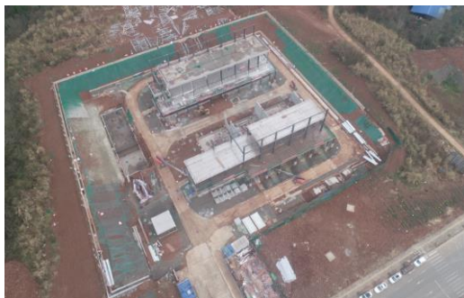
变电站站区建构筑物施工
