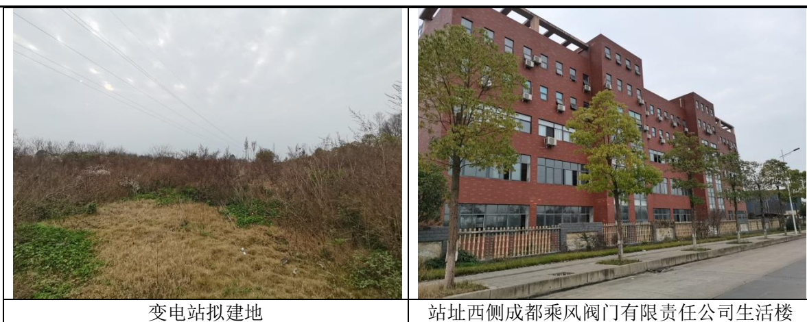
图 2-1 站址现状照片
