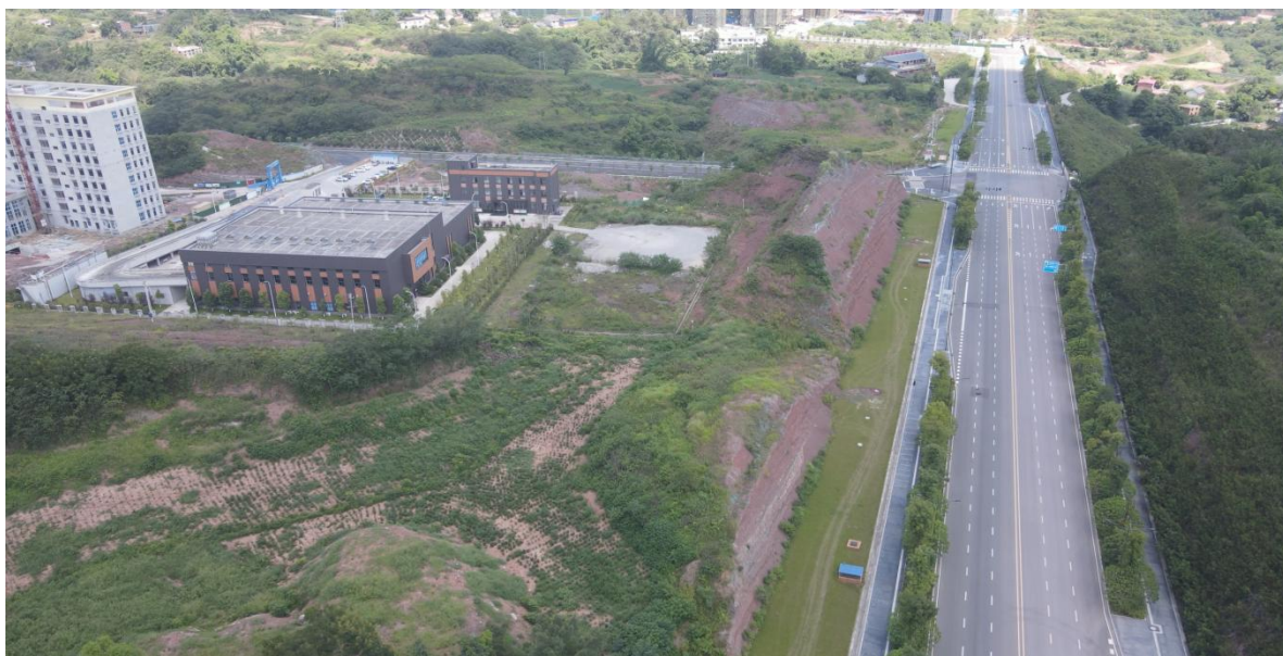
图 3-2 玉冯线 \pi 接线路沿线植被情况照片
