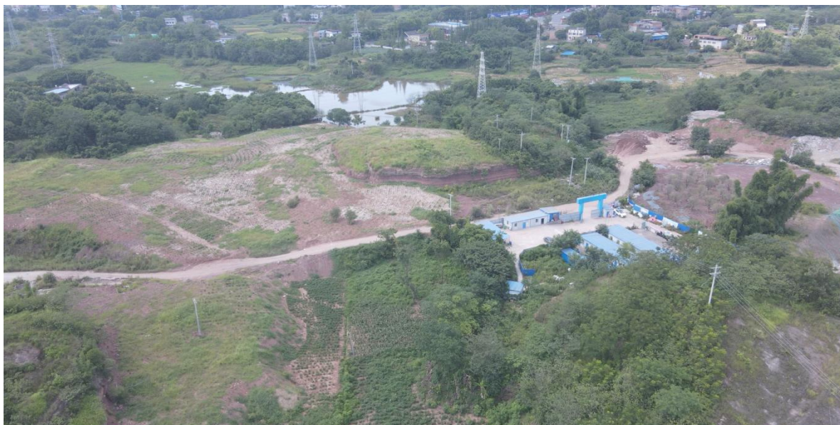
图 3-1 玉新三线 \pi 接线路沿线植被情况照片
