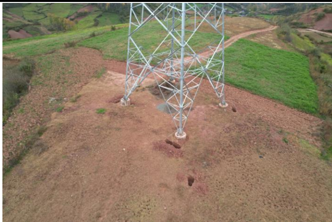
N2004#塔基已进行土地平整
