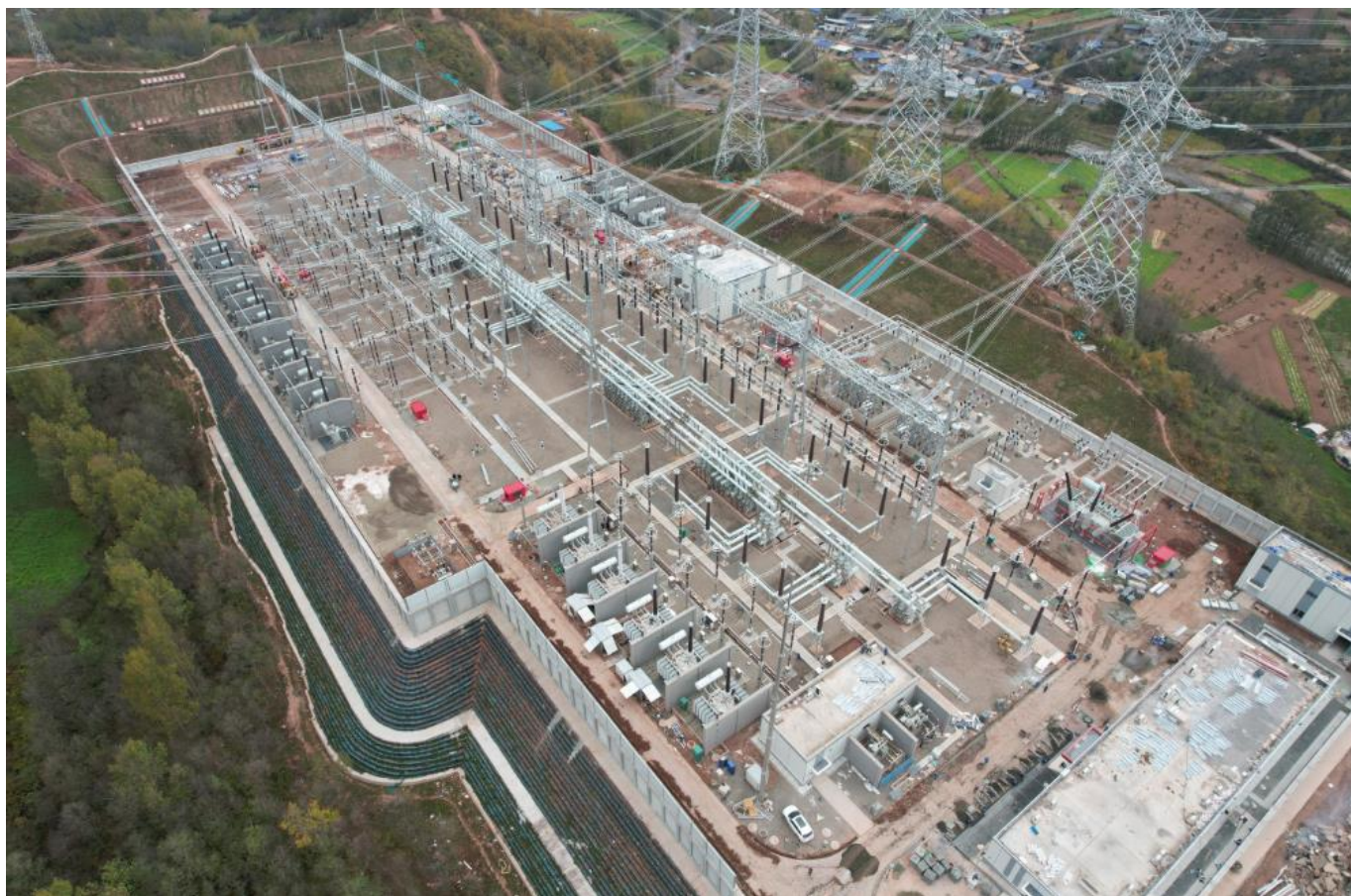
新建开关站现状航拍图
