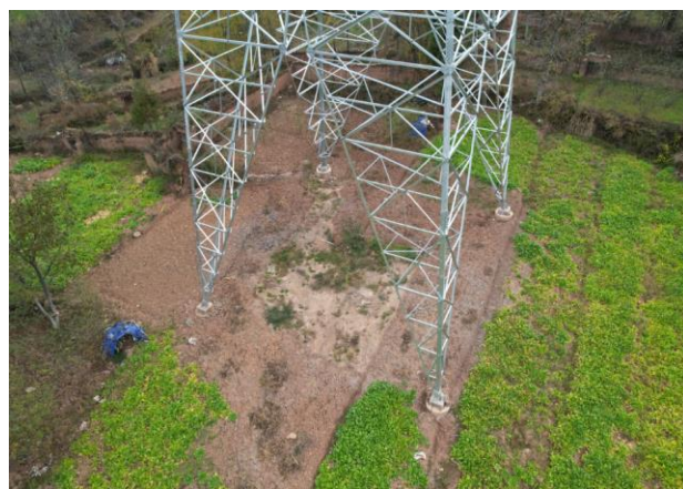
N2004#塔基已覆土
