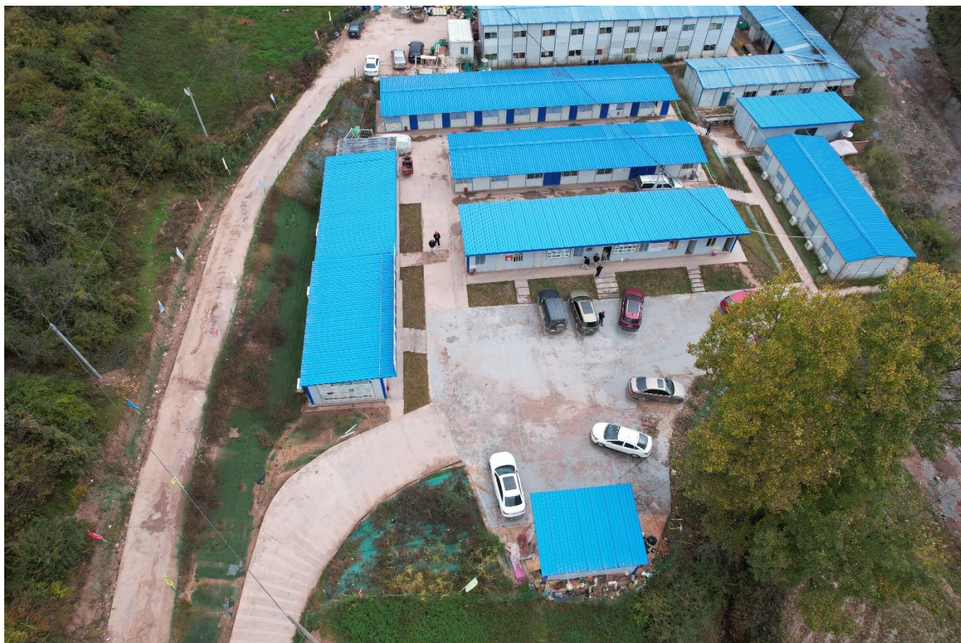
施工营地现状航拍图
