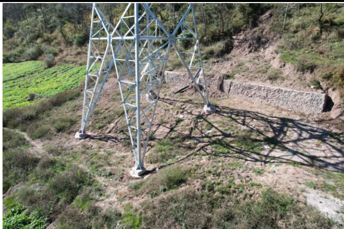
NR7005#塔基已绿化并实施了挡土墙
