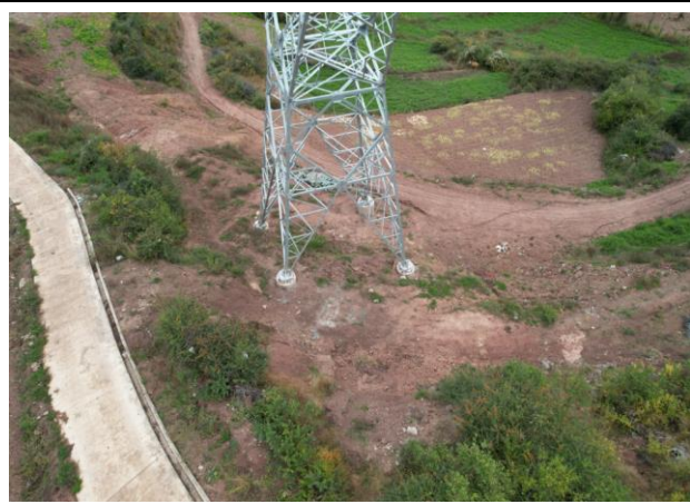
N1009#塔基已实施植物措施
