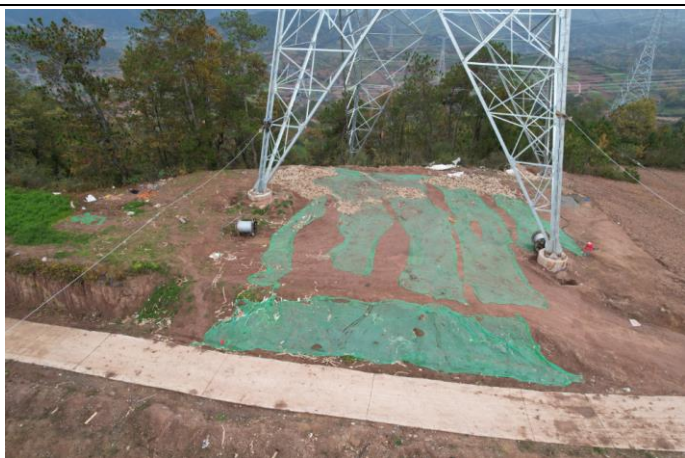
N2001#塔基已进行土地平整
