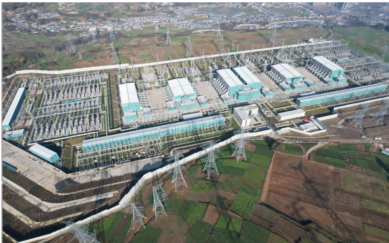
布拖换流站现状航拍图
