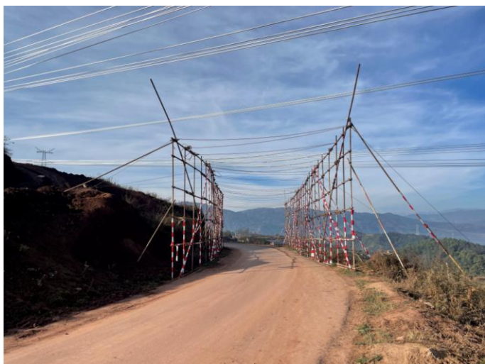
N5004#塔基跨越当地道路
