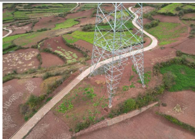
N2003#塔基已实施植物措施
