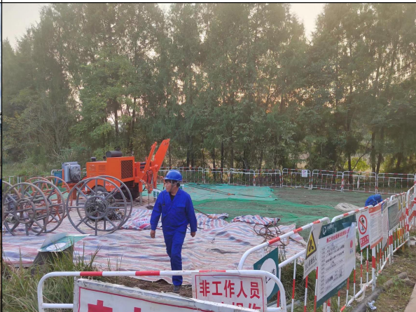
阆北-马鞍牵引站-N17 旁牵张场-施工中场地现状
