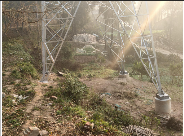
阆北-马鞍牵引站（N116）-导线展放后场地现状
