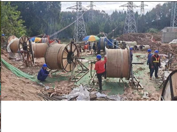
马鞍牵引站外牵张场-施工中场地现状
