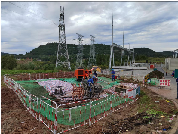
阆北-马鞍牵引站-N1 旁牵张场-施工中场地现状
