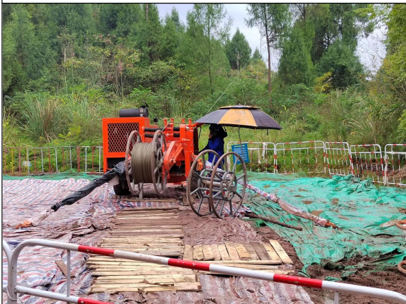
阆北-马鞍牵引站-N40 旁牵张场-施工中场地现状
