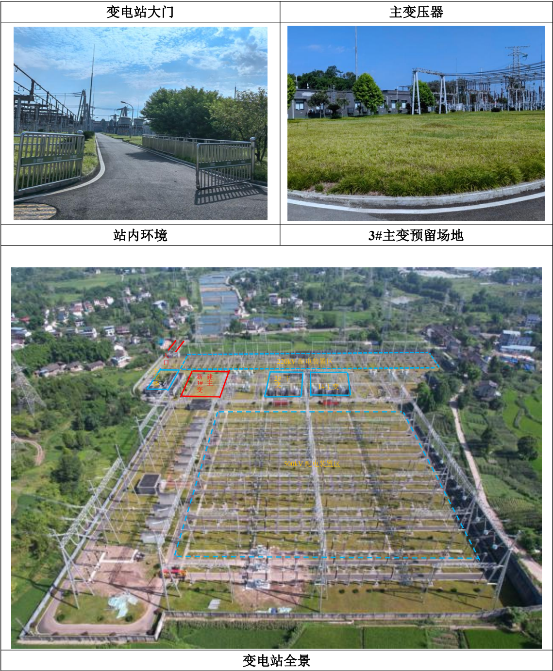
图 3-1 500kV 南充变电站现状
