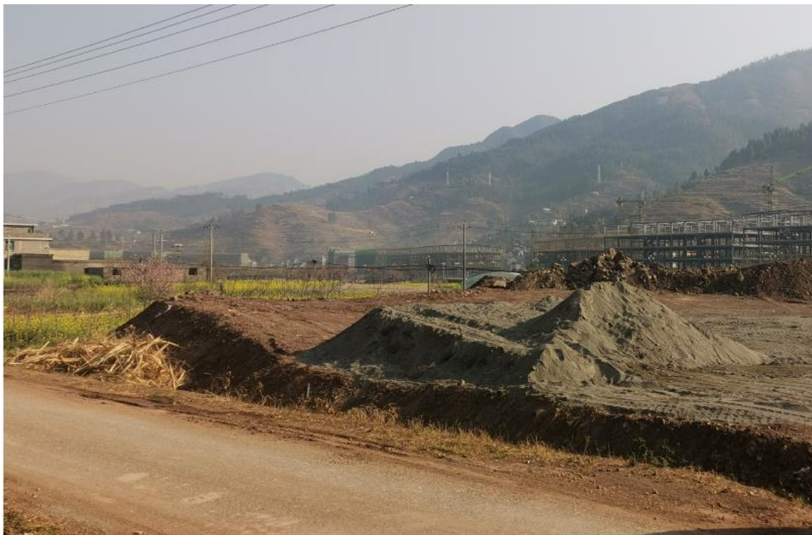
弃土场现场照片
