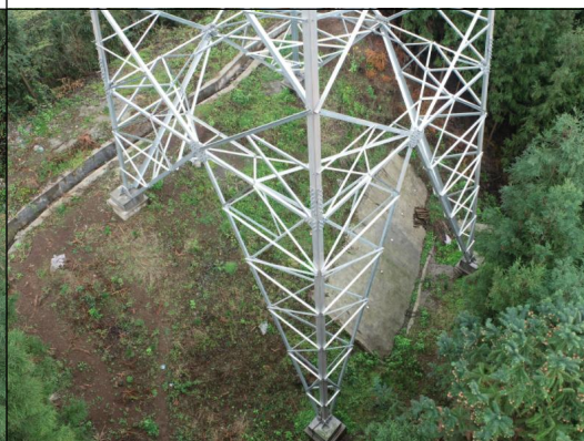
桑柏线 31#护坡及排水沟
