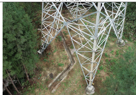
桑柏线 28#排水沟
