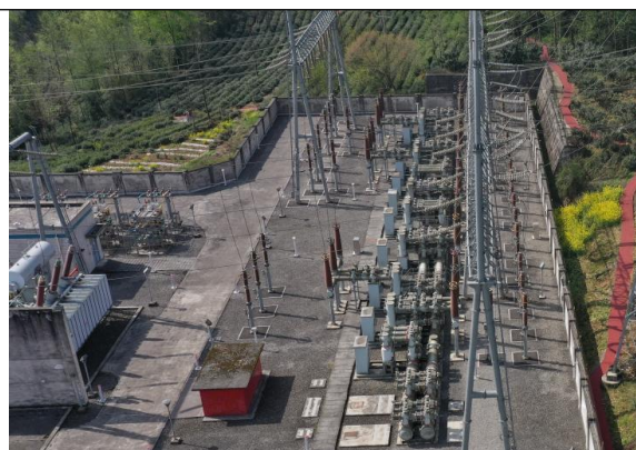
曲山间隔铺撒碎石
