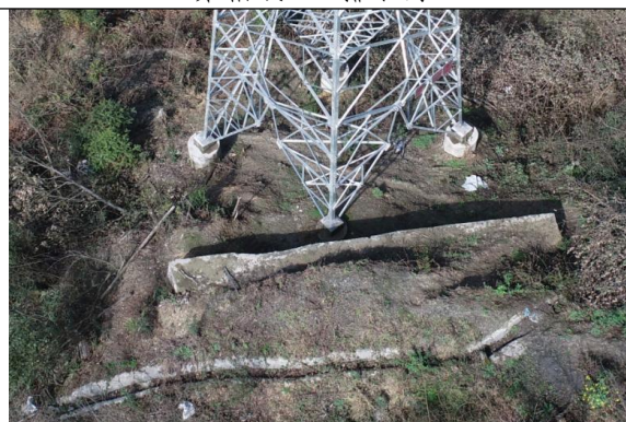
曲柏线 35#护坡及排水沟
