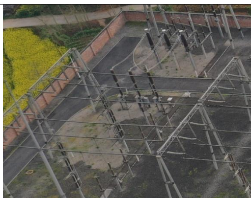
桑枣间隔扩建铺撒碎石
