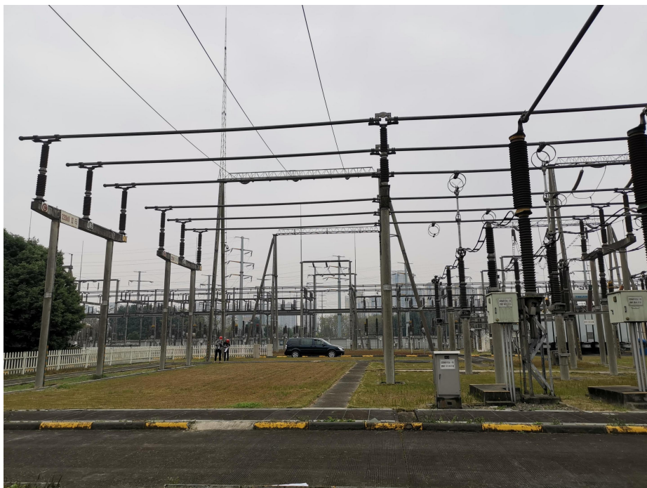
照片 2.1 鱼凫 220 千伏变电站扩建场地照片
