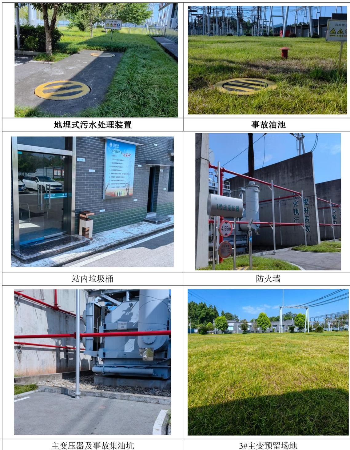
图 3-2 500kV 南充变电站内现有保护措施
