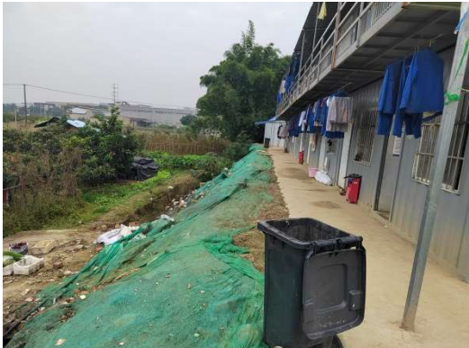
变电站施工施工场地临时遮盖
