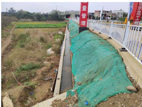
进站道路边坡临时遮盖
