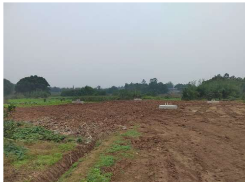
NR7 号塔施工场地土地整治
