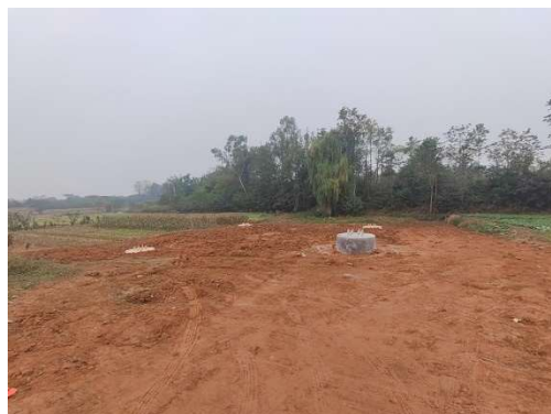
NL12 号塔施工场地土地整治
