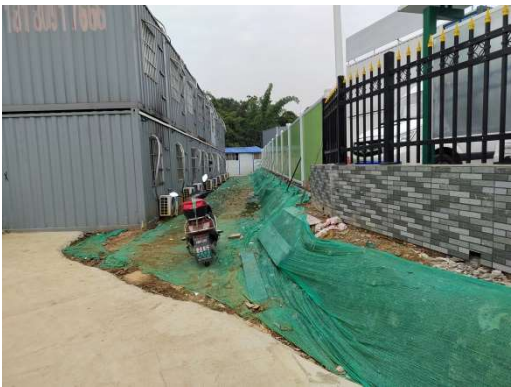
变电站施工施工场地临时遮盖
