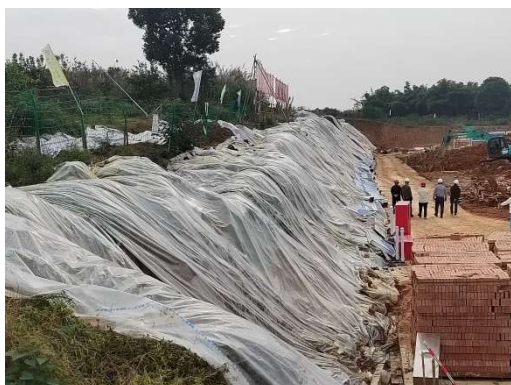
变电站边坡临时遮盖
