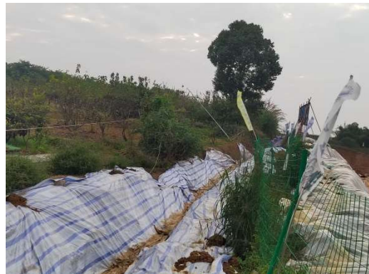
变电站临时排水沟临时隔离
