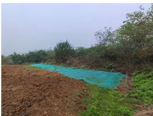
NL11 号塔裸露场地临时遮盖
