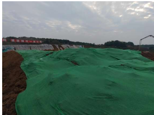
站区表土临时遮盖
