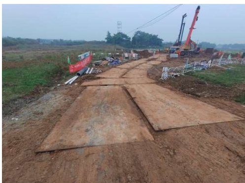
NR5 号塔施工道路钢板铺设
