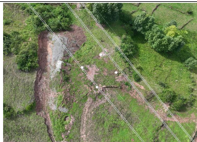
N4001塔基基础浇筑完成
