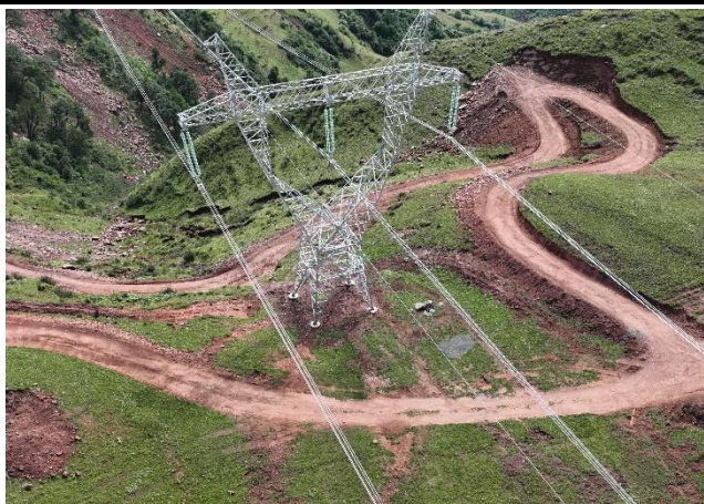
N1020塔基已架设完成并进行了场地平整
