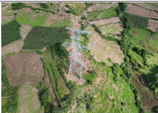
NL2004塔基场地平整已完成
