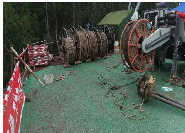
牵张场实施的临时防护措施
