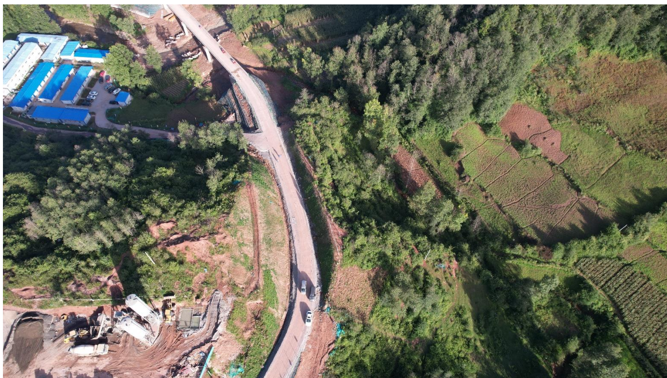
进站道路、施工营地现状航拍图
