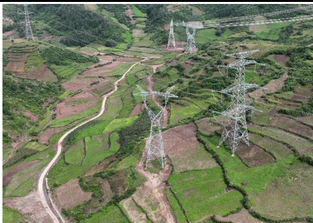
N4004塔基已实施植物措施
