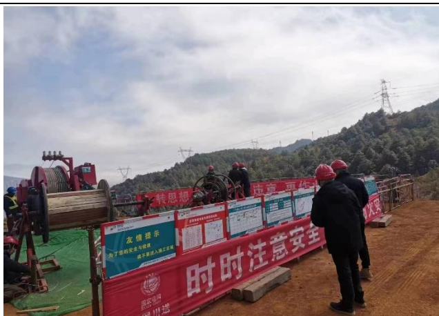
牵张场施工现场情况
