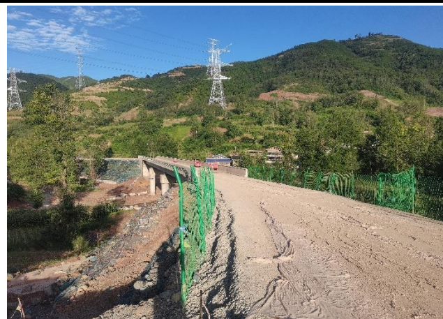
进站道路建设进度
