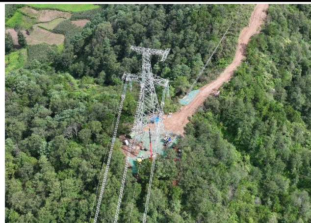
N4009塔基架线中
