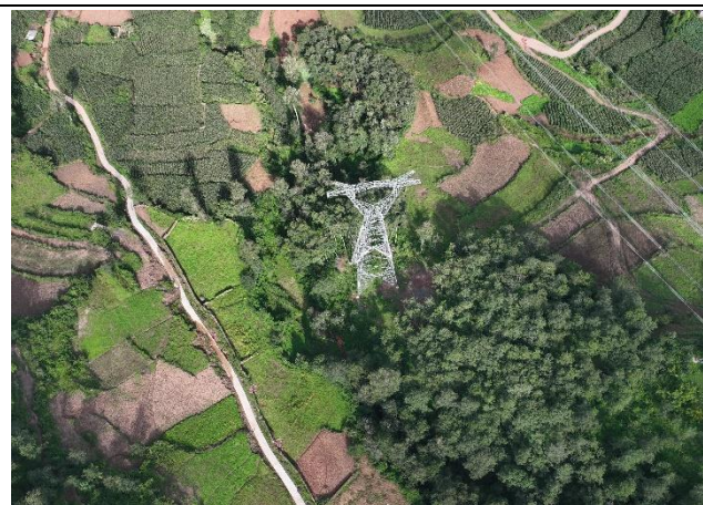
NL2002塔基已实施植物措施
