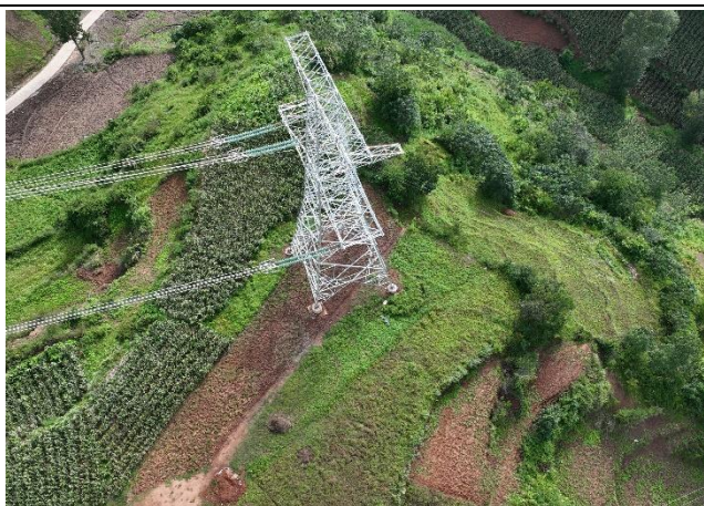
N2010塔基进行了场地平整及表土回覆
