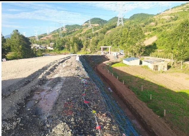
进站道路边坡挡土袋
