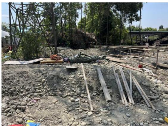
G5 号塔基基础开挖临时堆土裸露
