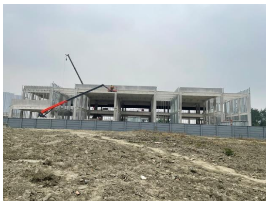
施工临时场地区、临时堆土区土地整治
