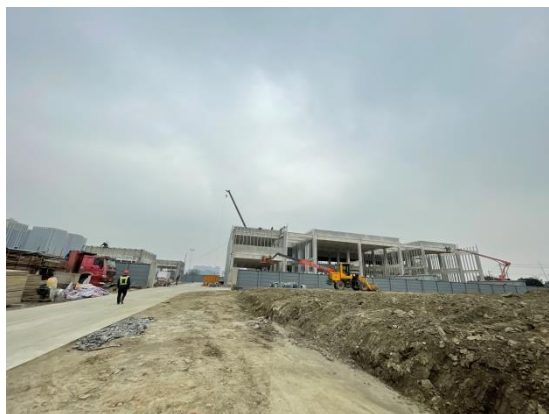
变电站进站道路
