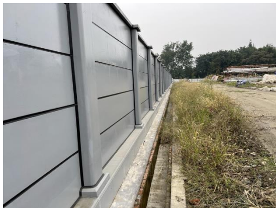
站外浆砌石排水沟
