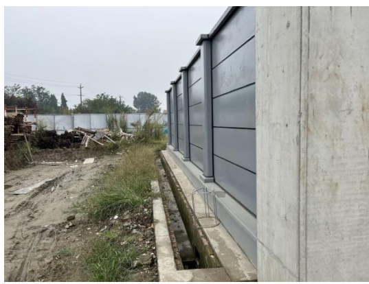
站外浆砌石排水沟
