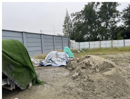
临时堆土区临时遮盖
