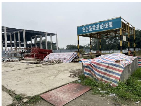
施工临时场地区临时遮盖
