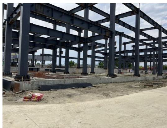
站内配电装置楼建筑物基础已建好
