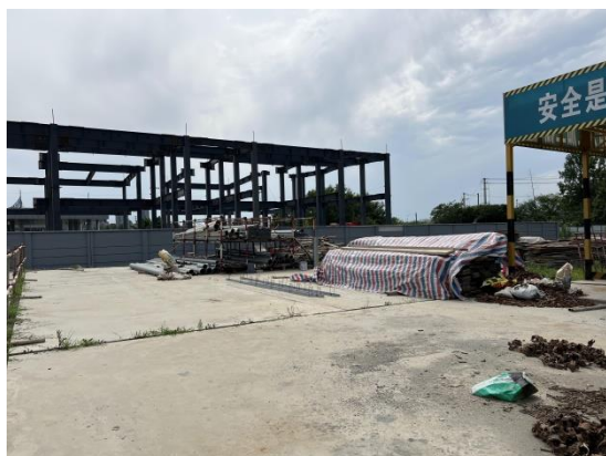
施工临时场地区临时遮盖
