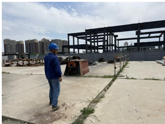
施工临时场地区和站内建筑物
