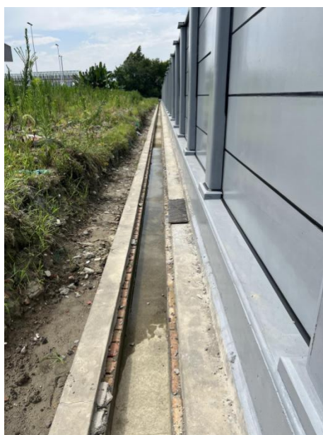
站外浆砌石排水沟
