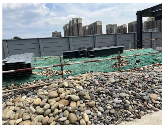
砂石临时遮盖
