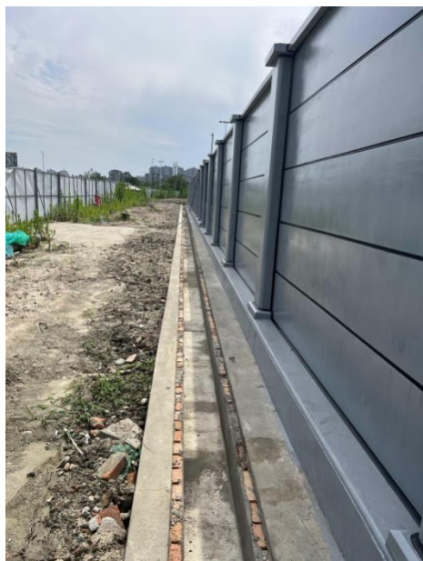
站外浆砌石排水沟
