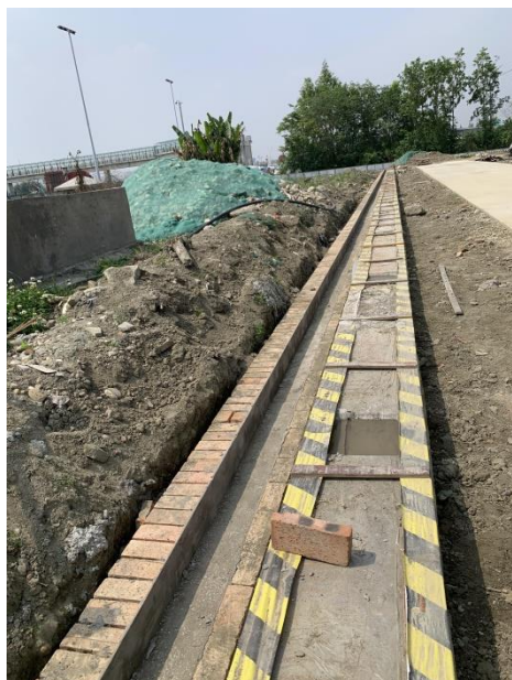
临时遮盖和排水沟
