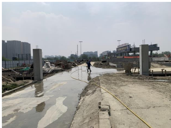
变电站进站大门处
