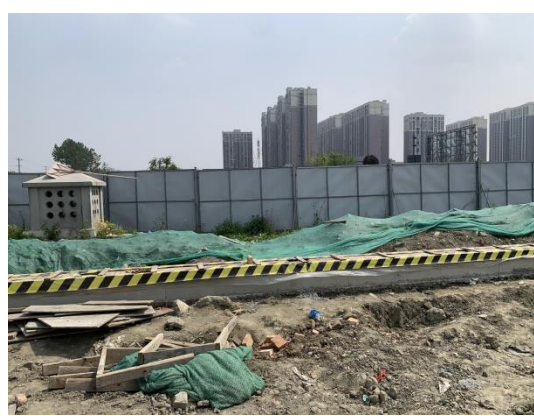
临时堆土区临时遮盖
