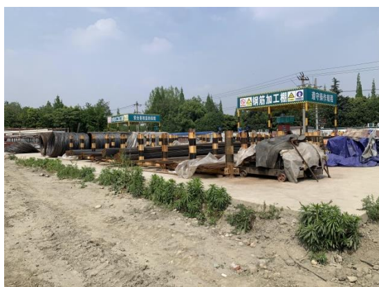
施工临时场地区防雨布临时遮盖
