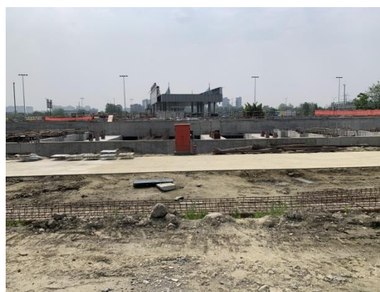
配电装置楼基础已建好
