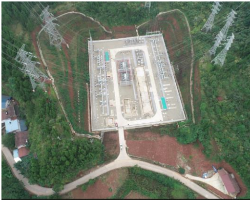
变电站内硬化铺设碎石，站外设置截排水沟、植草护坡，施工场地已复耕、土地整治、撒播草籽
