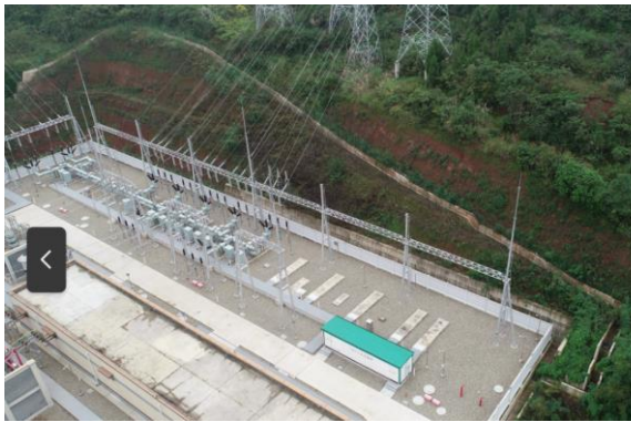
变电站新建工程区场内铺设碎石及边坡防护
