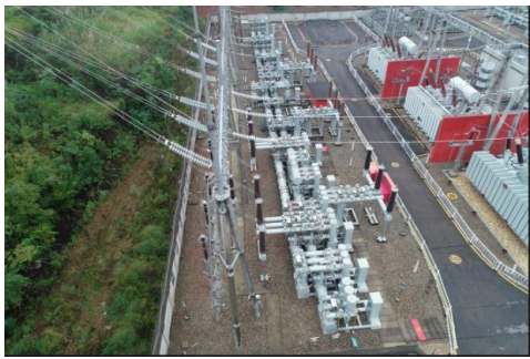
清河 220kV 变电站间隔扩建工程区碎石铺设
