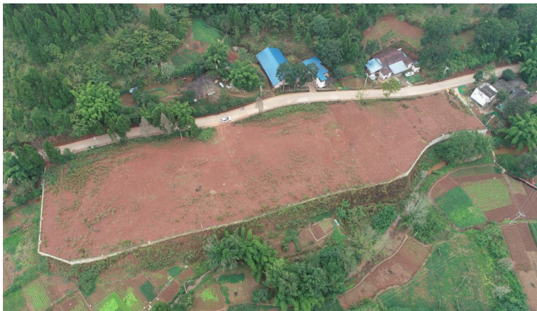
弃渣场挡墙、土地整治、复耕、撒草绿化
