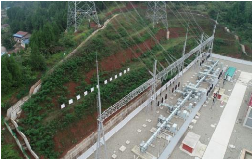
变电站新建工程区截水沟和边坡整治
