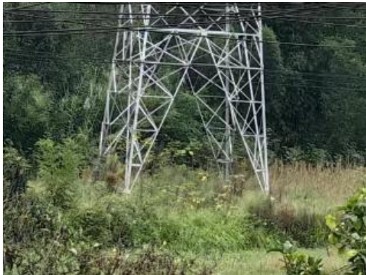
双回新建段-19#塔
