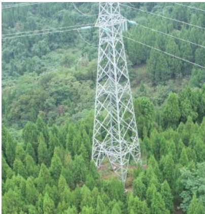
双回新建段-9#塔
