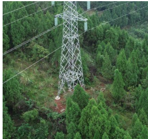
双回新建段-14#塔
