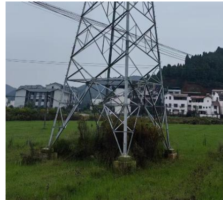
双回新建段-20#塔
