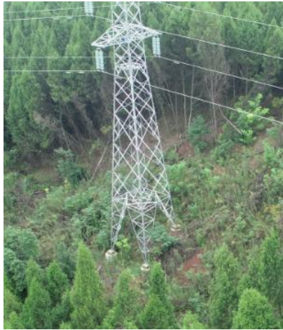
双回新建段-7#塔
