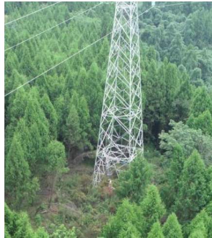
双回新建段-8#塔
