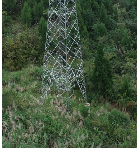
双回新建段-15#塔
