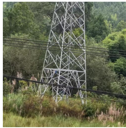
双回新建段-18#塔
