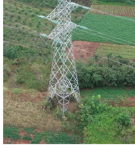
双回新建段-16#塔
