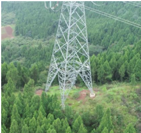
双回新建段-12#塔
