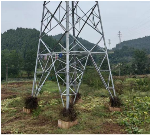
双回新建段-17#塔
