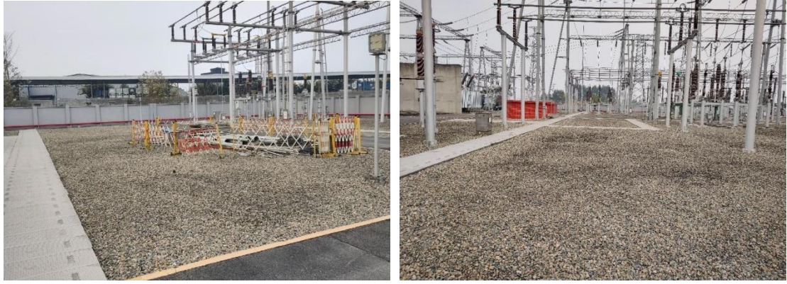
站内地坪现状（碎石压盖）
