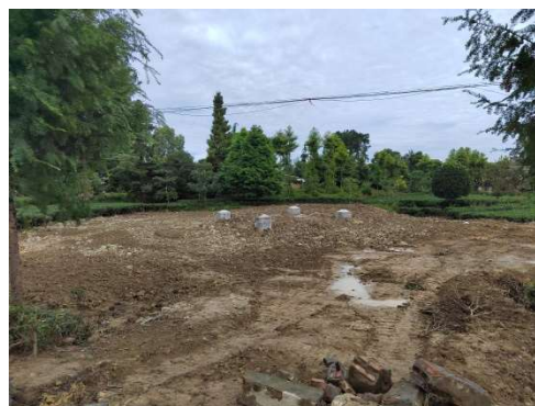
NB61 号塔基施工场地现状
