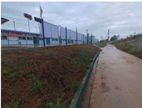
进站道路排水沟
