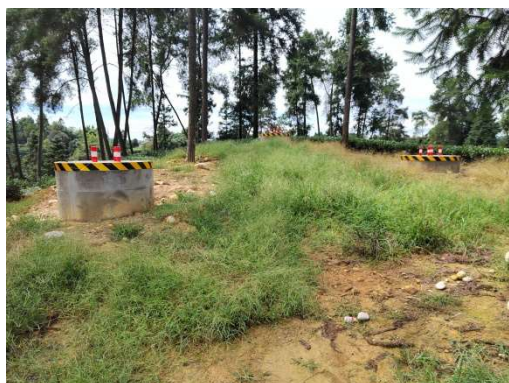
NA81 塔基施工场地植被恢复
