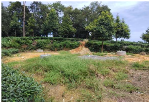
NB55 号塔基施工场地现状
