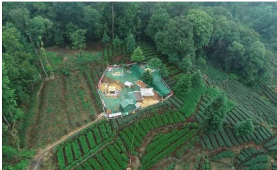
NB55 号塔基施工场地现状
