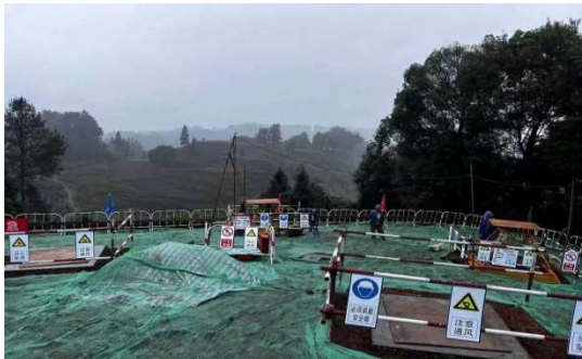
NA56 号塔基施工场地现状
