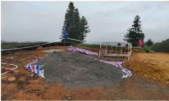
NB51 号塔基施工场彩条布临时隔离
