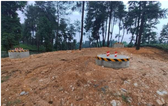
NA81 塔基施工场地平整
