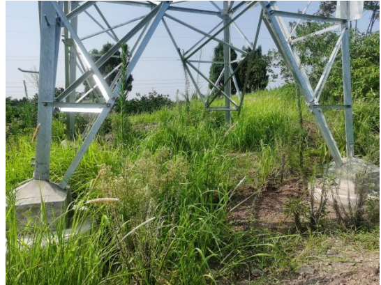
Z21 塔基绿化情况
