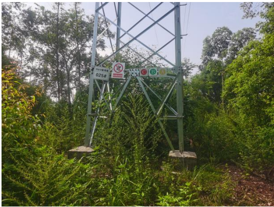
Z11 塔位（银山-全安线路）植被恢复情况
