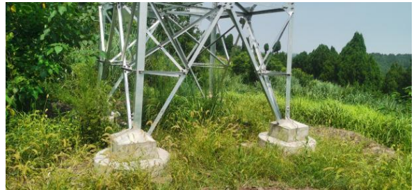
Z6 塔基绿化情况
