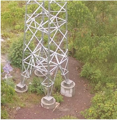
Z8 塔基绿化情况
