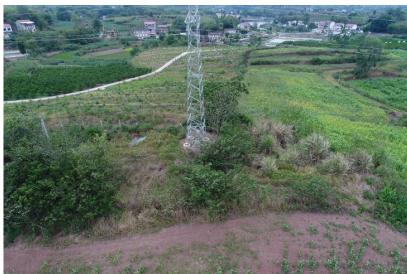
Z2-9 塔基绿化情况
