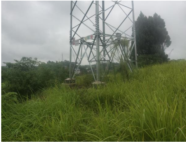
Z6 塔基绿化情况
