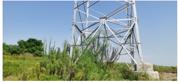
Z4 塔基绿化情况
