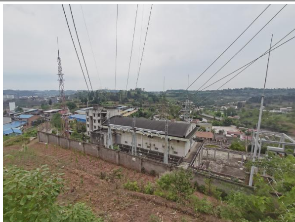
银山变电站间隔扩建情况 1
