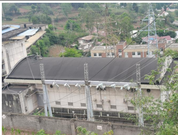
银山变电站间隔扩建情况 2
