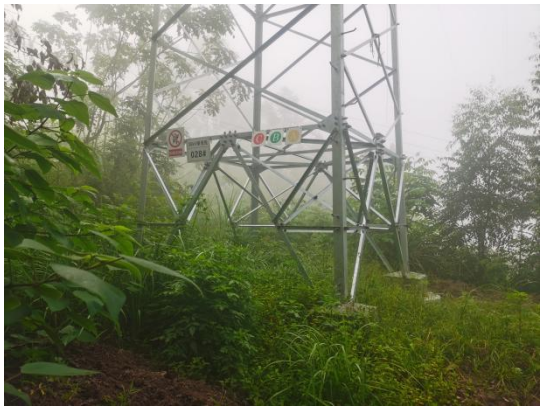
Z14 塔位（银山-全安线路）植被恢复情况
