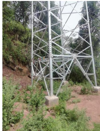
Z7 塔基绿化情况
