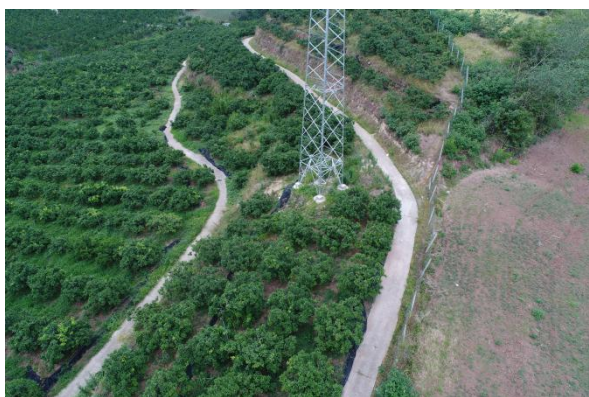
Z3 塔基绿化情况
