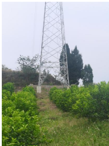
Z7 塔基绿化情况
