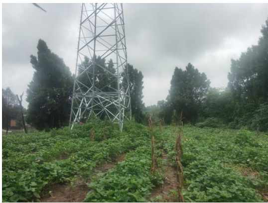
Z8 塔基绿化情况
