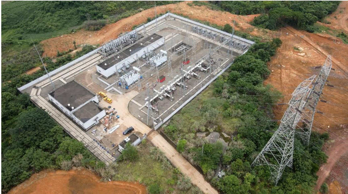
图 3-4 已建毛家湾 220kV 变电站现状
