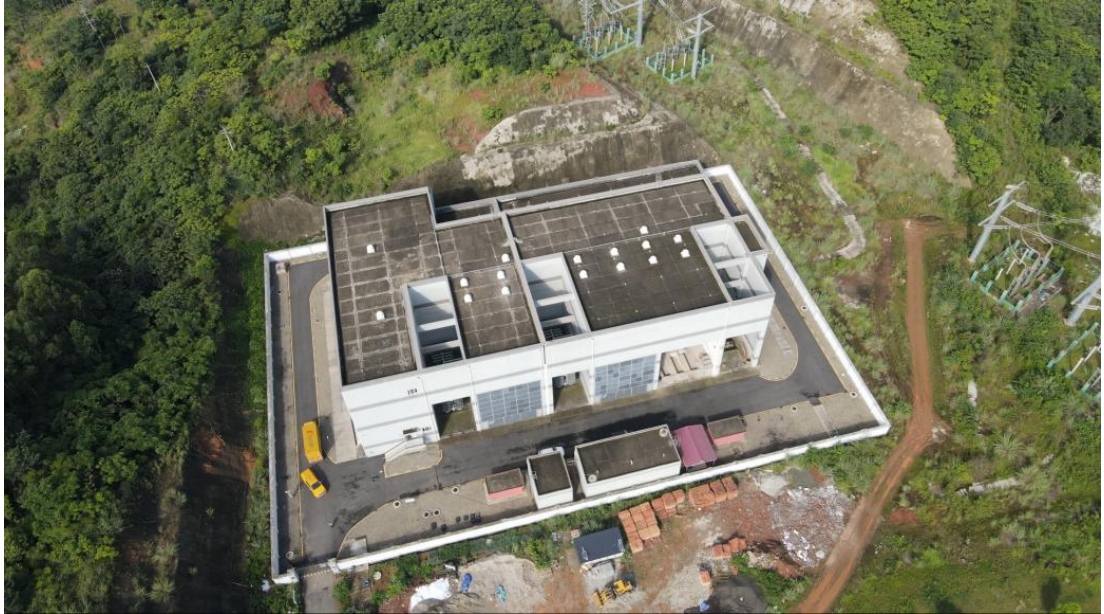
图 3-3 已建罗家店 220kV 变电站现状
