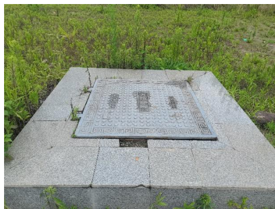
JK 段为已建综合管廊处植被情况
