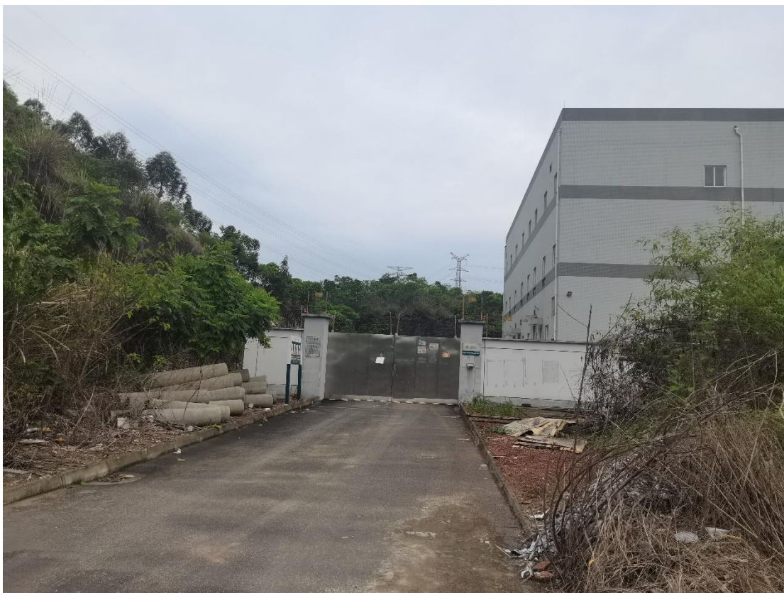
图 3-5 已建罗家店 220kV 变电站现状
