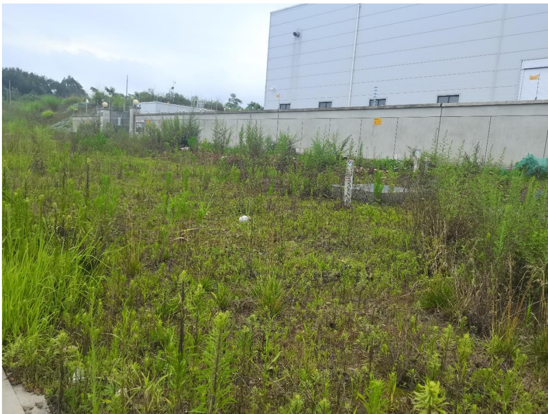
图 3-6 已建科智 220kV 变电站现状
