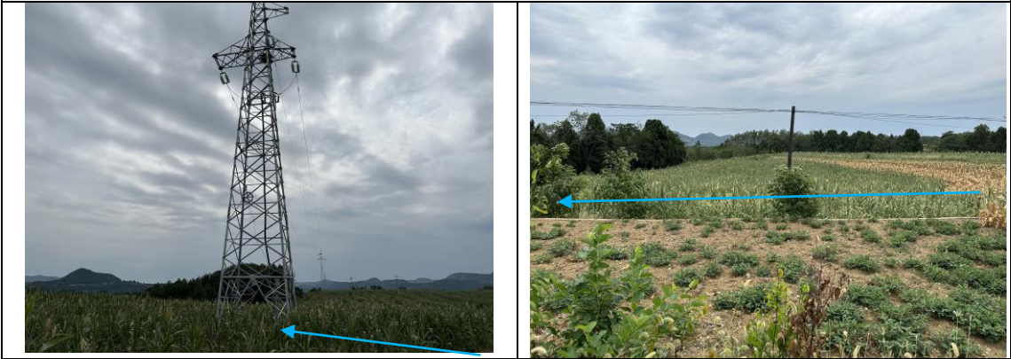
香山 35 千伏变电站西侧已建电缆终端塔 架空线路路径沿线情况 1
