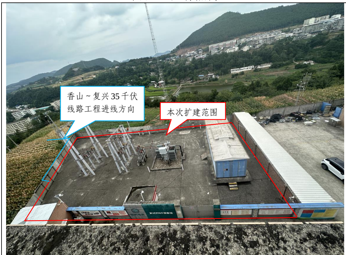
复兴 35 千伏变电站现状
