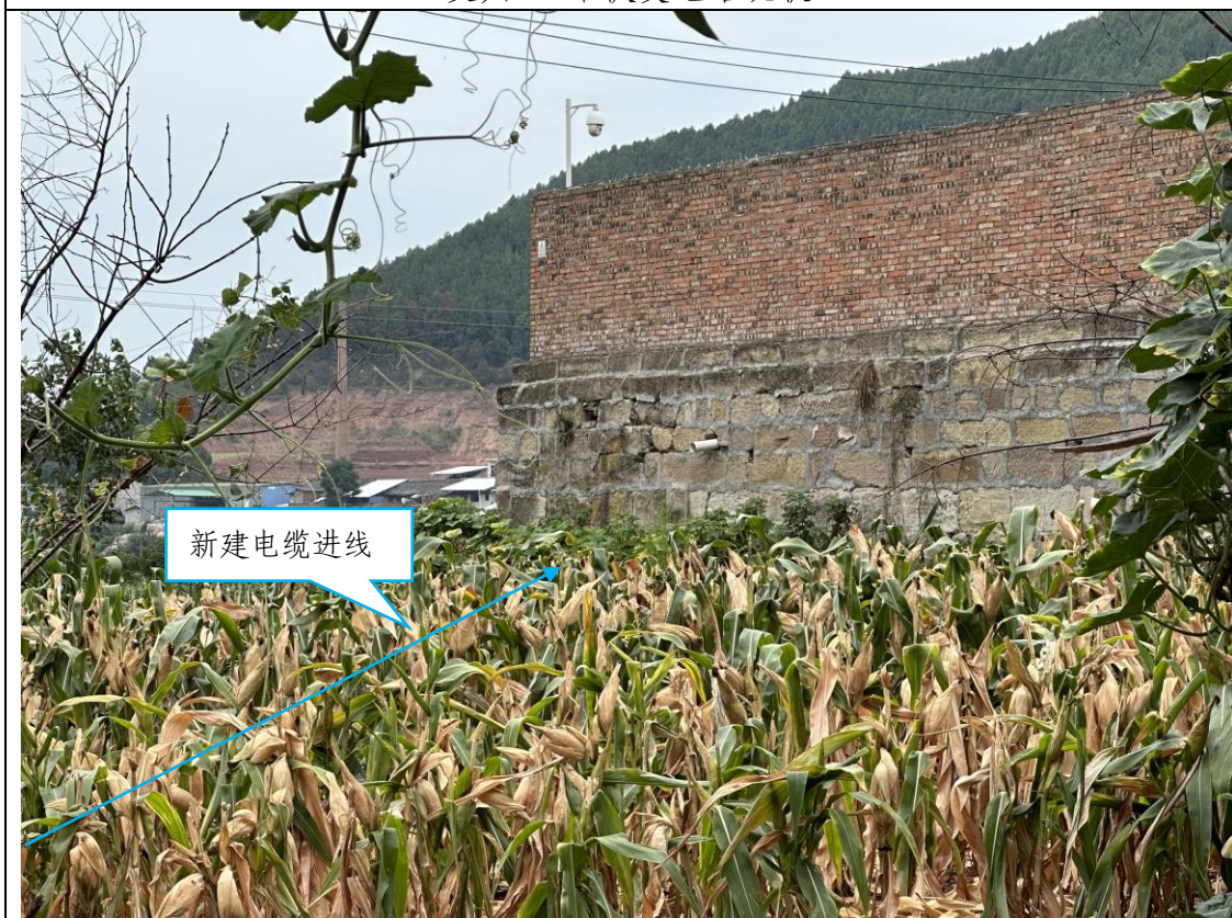
复兴 35 千伏变电站进线侧现状
