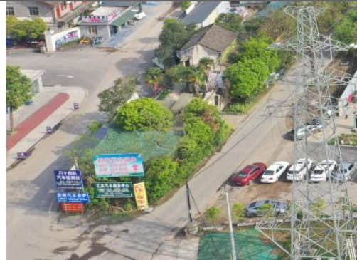
施工道路区种草绿化
