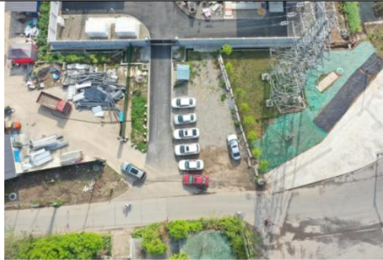
施工道路区种草绿化
